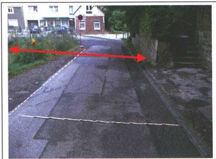
Borner Straße 13, 15 Hier werden 6,00 m Ausbaubreite gefordert. Zollstock 3,00 m Fahrbahnbreite derzeit ca. 3,20 m
