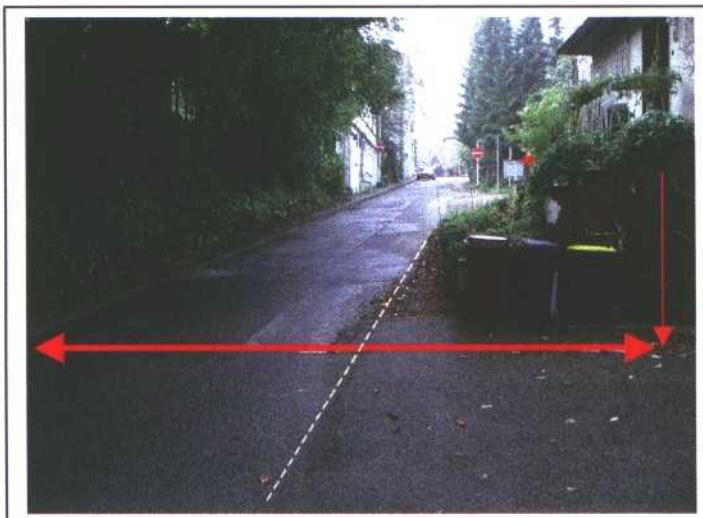
Borner Straße Hausnummer 13,15 (Garageneinfahrt) Fahrbahnbreite ca. 3,20 m Geforderte Ausbaubreite 6,00 m Die Straße endet vor einer Wand.
