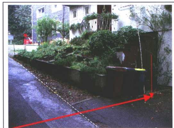
Borner Straße Hausnummer 13,15 Fahrbahnbreite derzeit ca. 3,20 m Geforderte Ausbaubreite 6,00 m Die Straße endet vor einer Wand.
