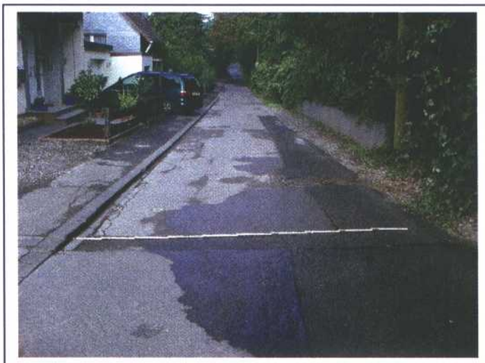
Borner Straße / Einmündung Borner Hofwiese Zollstocklänge 3,00 m Fahrbahnbreite 3,24 m Ausbaubreite (incl. Gehweg) 3,95 m
