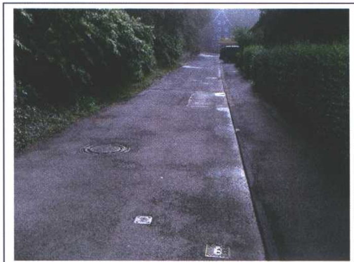
Borner Straße Hausnummer 19 - 25 Fahrbahnbreite ca. 3,20 m Ausbaubreite (incl. Gehweg) 4,12 m
