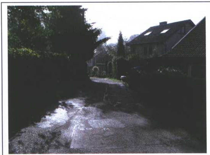
Borner Straße /Einmündung Herichhauser Straße
