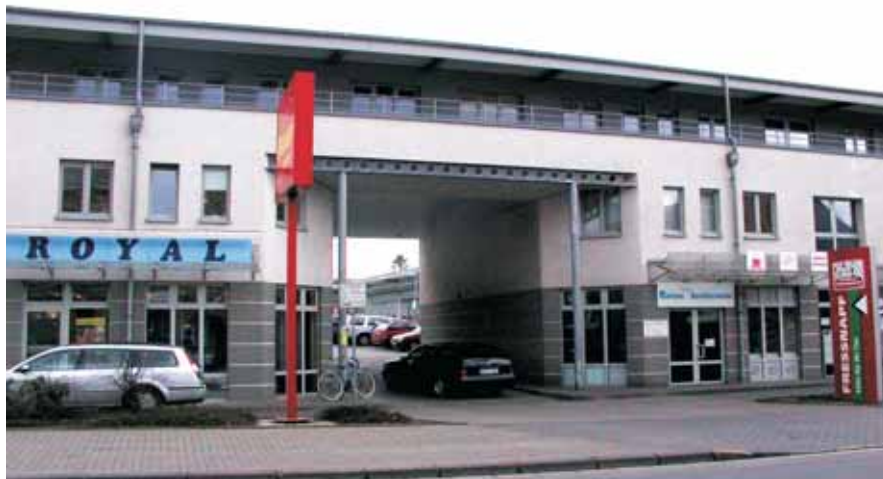
Penny-Markt 3 geschossiges Gebäude integrierter Standort Parkplatz im Innenhof
