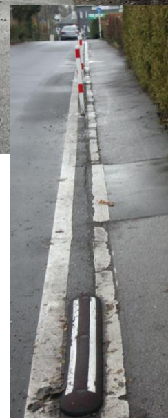
Beispiel Poller und Kunststoffkanten zur Sicherung des Gehwegs (Beispiel Böhler Weg)
