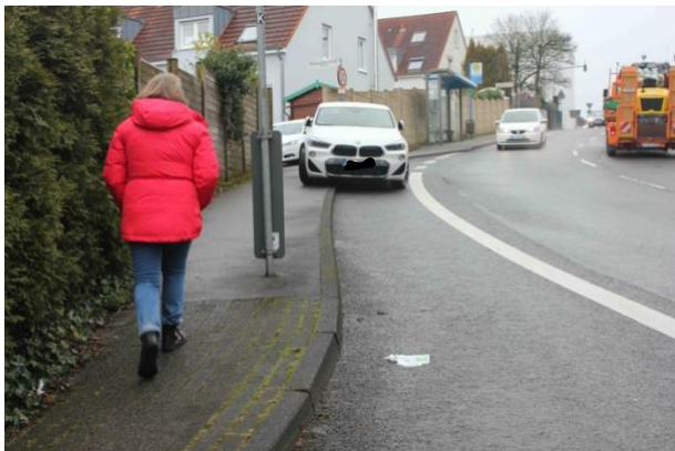
Beispiel Poller und Kunststoffkanten zur Sicherung des Gehwegs (Beispiel Böhler Weg)
