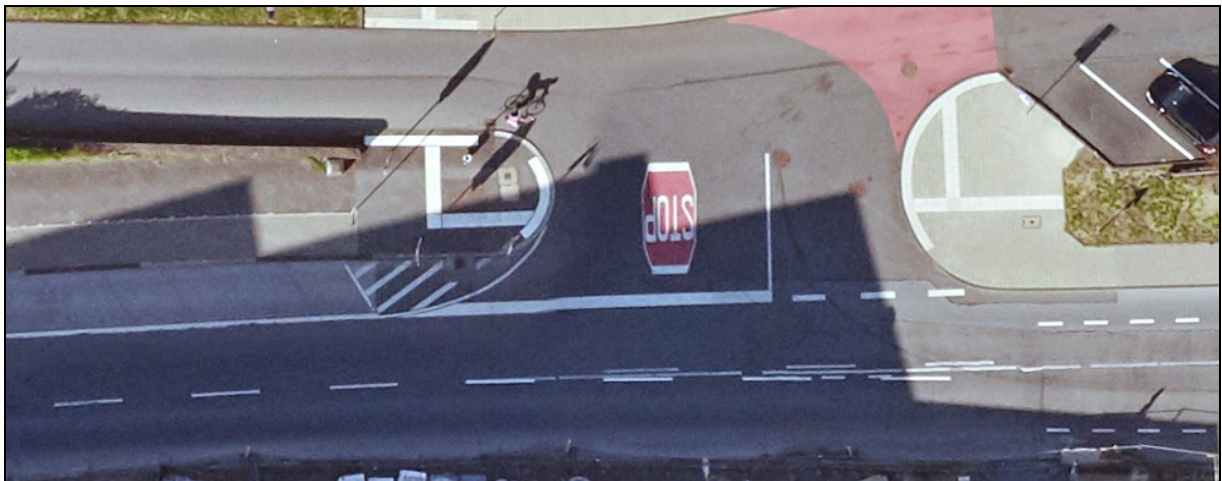
Abb.: Einmündungsbereich Südstraße / Immermannstraße
