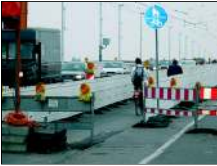
Gute Überleitung vom Gehweg auf die Fahrbahn zu Beginn ...
