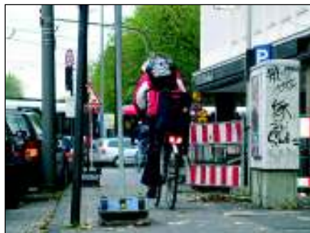
Schilder auf dem Radweg müssen nicht sein, die Aufstellsockel reduzieren die Radwegbreite unnötig!
