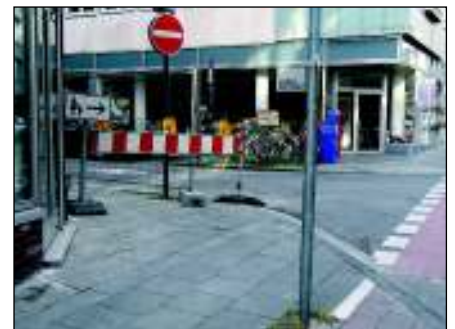
Fehlende Tastleiste an der Absperrung: Weil der Langstock keinen Widerstand findet, läuft der Blinde gegen die Bake.
