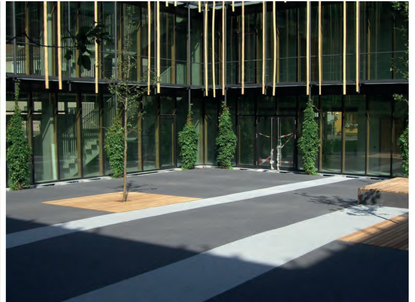
Asphalt mit farbiger Beschichtung, Einbau in Streifen (kein Farbbeispiel)
