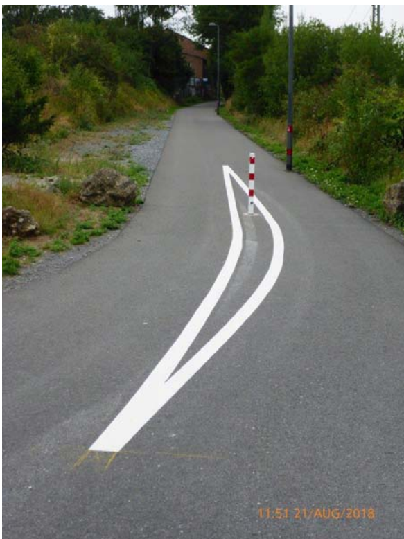
Nordbahntrasse Bereich Herderstraße
