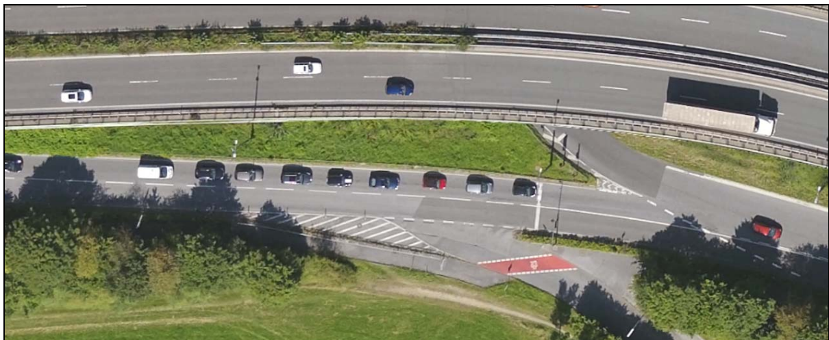
Abb. 1: Kreiszufahrt aus Richtung Westen – heute weitestgehend ungenutzte rechte Fahrspur
