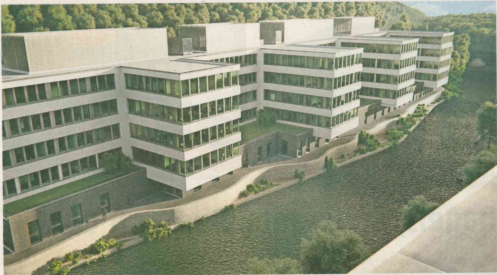
Zukünftig wird die Architektur der Bauten im Werk Laaken der Qualität der dort entwickelten und produzierten Artikel entsprechen.
