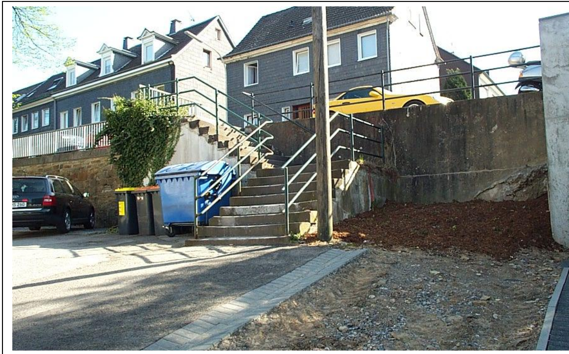
Foto 1: Treppenbauwerk mit 2 Treppenläufen
