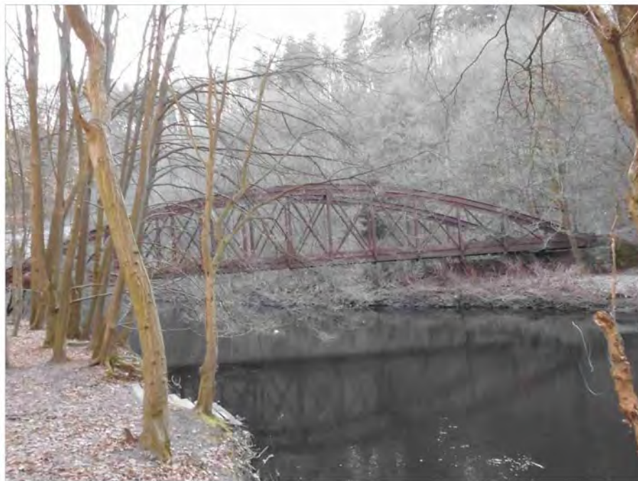
Brücke aus nördlicher Richtung
