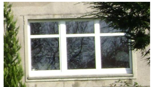
Walmdach mit Dachgaube Beispiele der ursprünglichen Fensteraufteilung,
