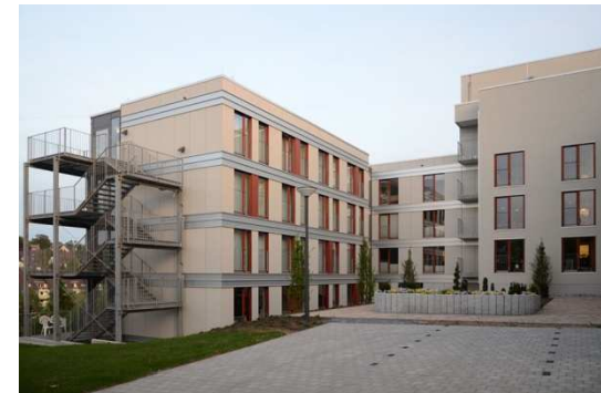
Neubau APH in Ronsdorf
