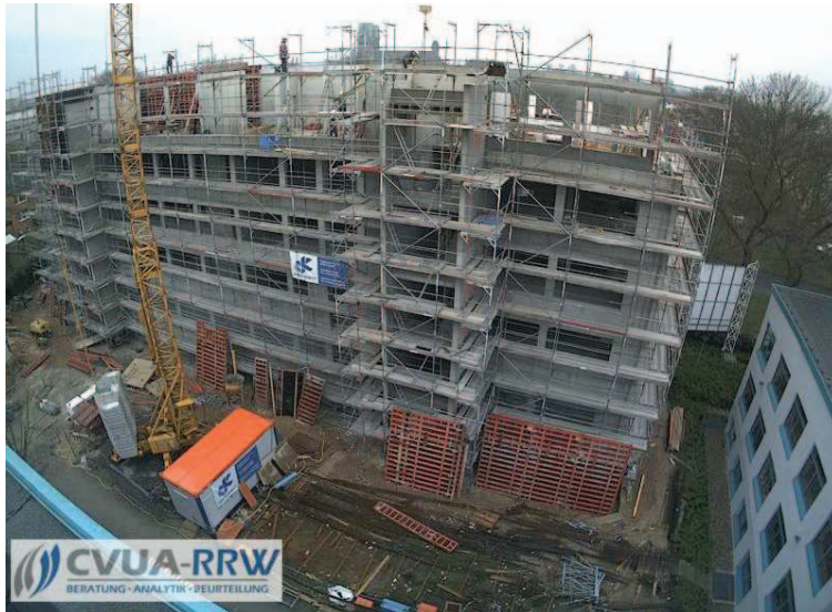
Stand der Bauarbeiten am 01.04.2010
