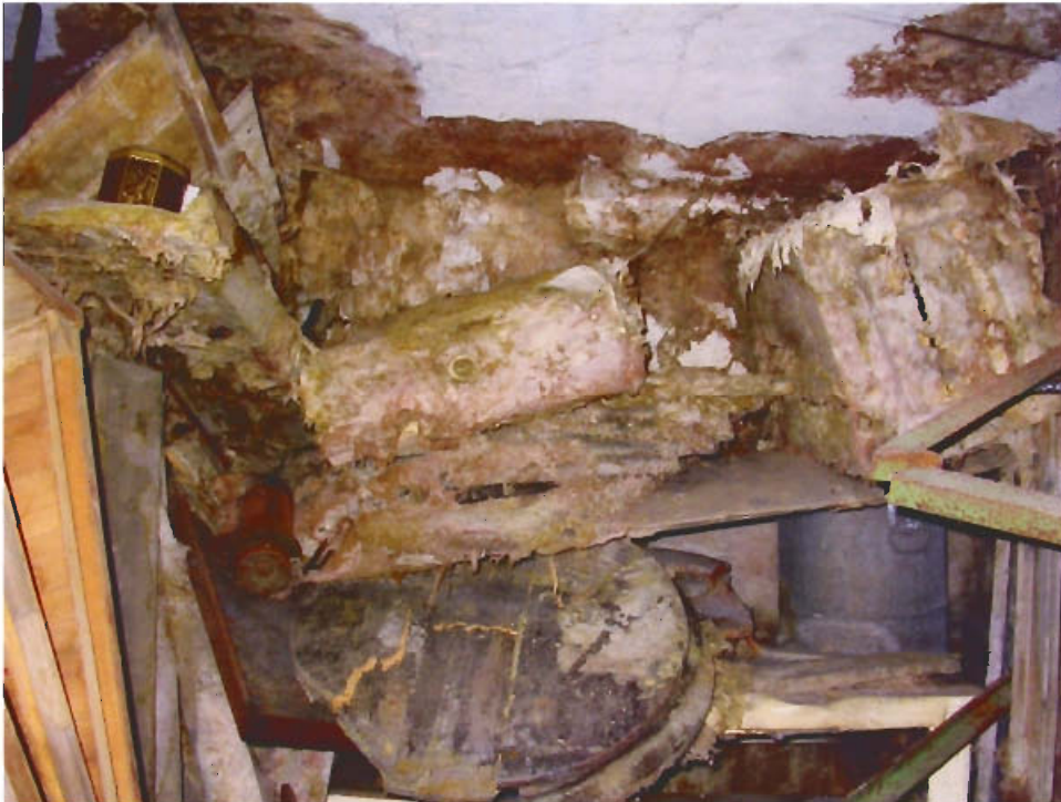
Bild 4: Myzelüberwachungen vom Echten Hausschwamm im straßenseitigen Hausanschlussraum im Kellergeschoss
