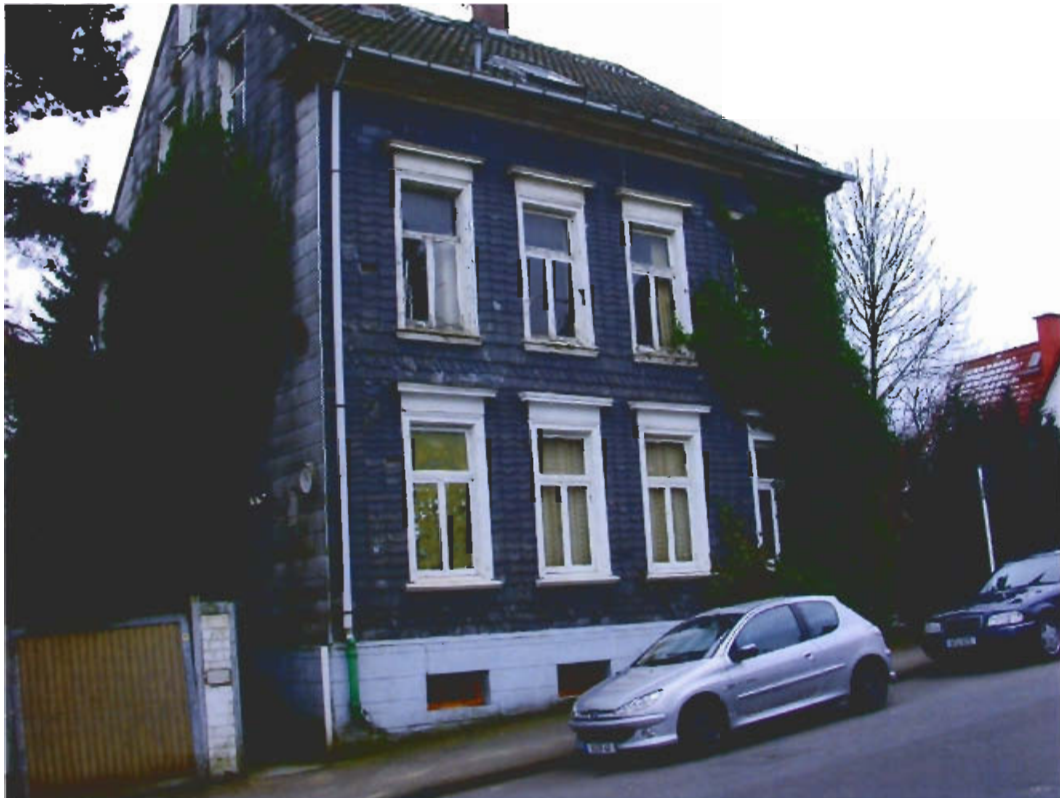
Bild 1: Nördliche Traufseite und östliche Giebelseite des Gebäudes Talsperrenstraße 61 in Wuppertal
