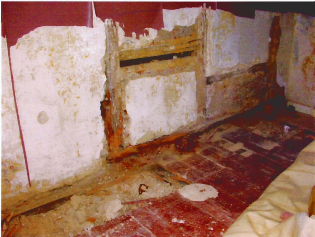
Bild 6: Bauteilfreilegungen an der westlichen Giebelseite des Gebäudes
