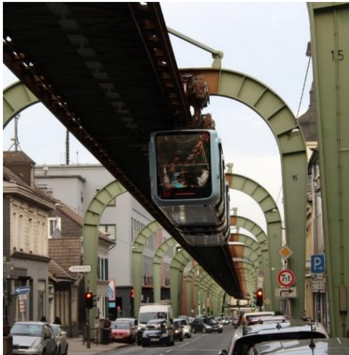
Abbildung 3: Bildung einer horizontalen Raumkante durch die Schwebebahn
