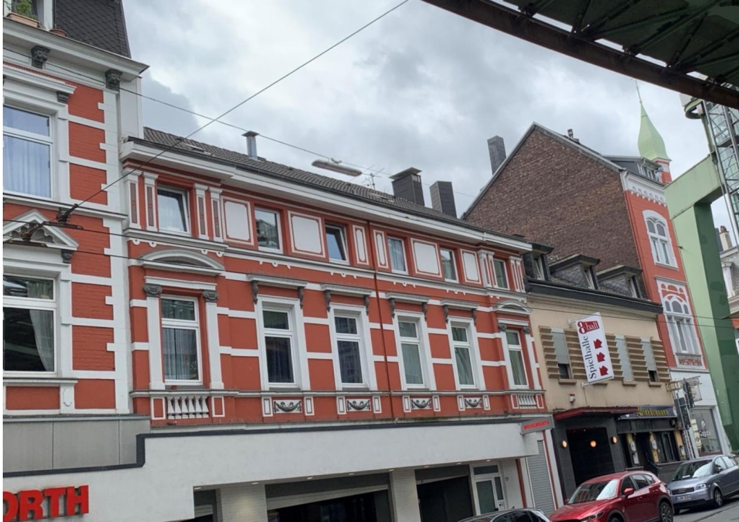
Abbildung 5: Höhenversprünge zwischen Gebäuden verschiedener Epochen
