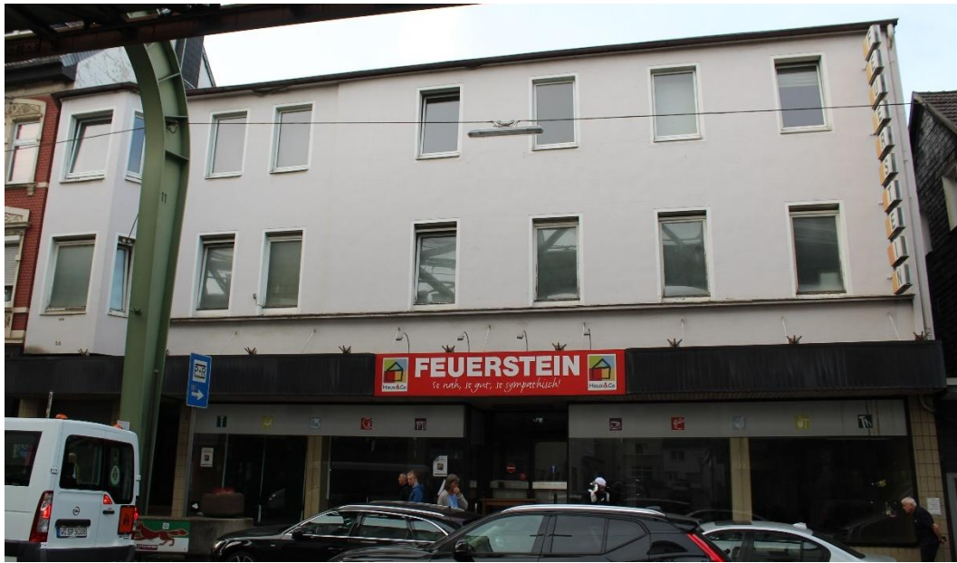
Abbildung 12: Beispielbild für Gebäude mit veränderter Fassade 20
