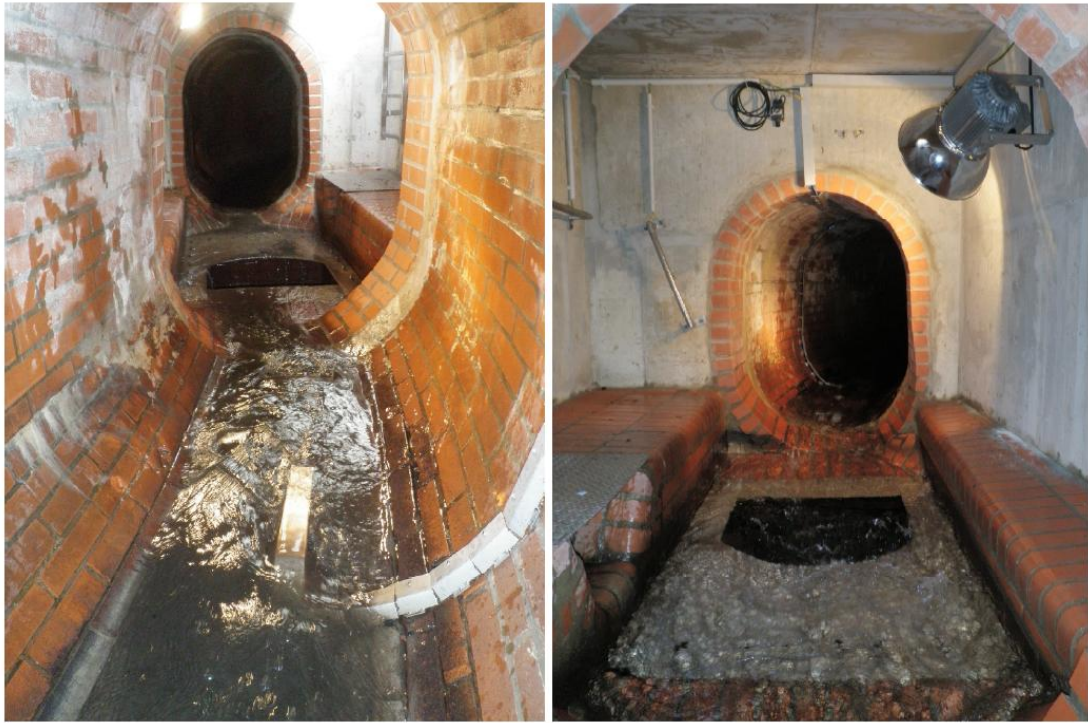
Abbildung 12: Photometersonde, Springüberlauf und Scheinwerfer am Beispiel des VZW73
