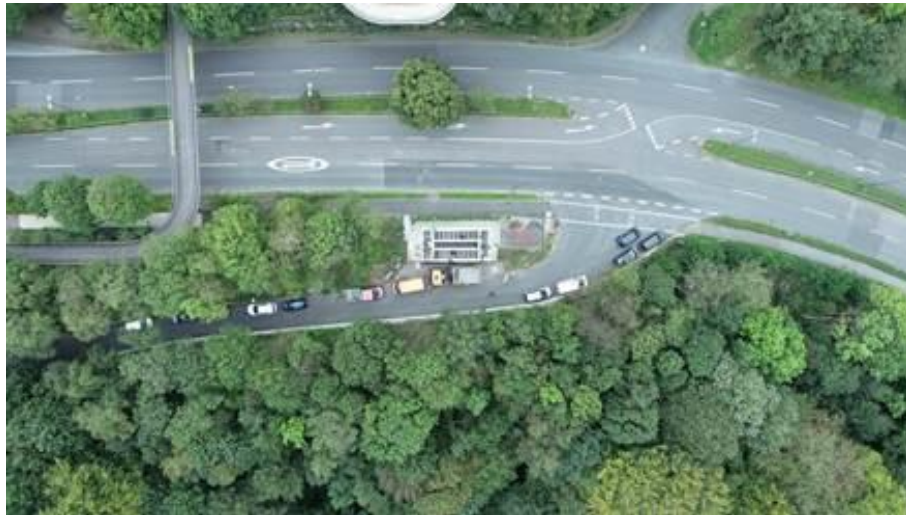
Abbildung 16: Luftbild mit Standort des Technischen Regenwasserfilters
