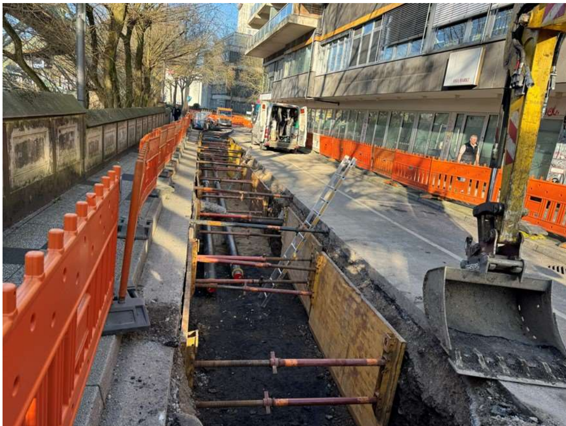
Abb. Leitungsraben in der Schloßbleiche (Baulos 2 WSW)
