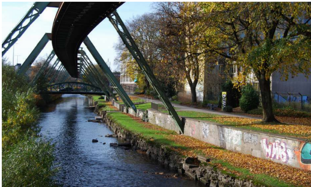
06 Zugangsmöglichkeiten zur Wupper sind dabei nur begrenzt im Stadtraum vorhanden und stehen oft im Konflikt mit Maßnahmen zum Natur- und Hochwasserschutz. © urban catalyst
