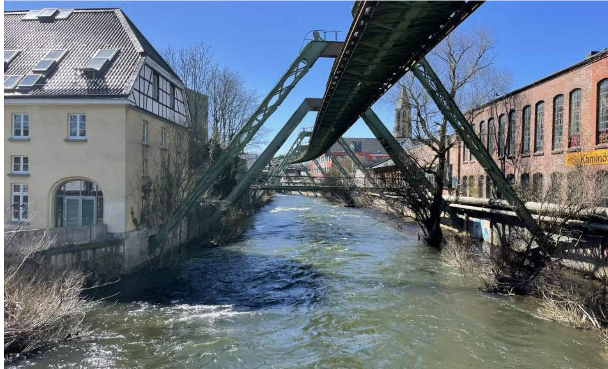
17 An vielen Abschnitten der Wupper ist ihr Ufer durch Gebäude oder Mauern begrenzt. Auch wenn einige Teile bereits renaturiert wurden, tritt die Wupper bei starken Regenfällen über ihre Ufer.
