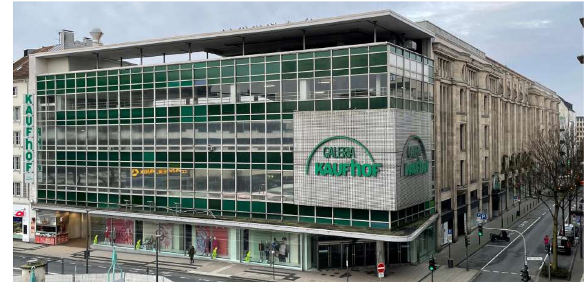
19 Der ehemalige Kaufhof im Elberfelder Citykern stellt eine Schlüsselimmobilie für die zukünftige Innenstadtentwicklung dar. © Stadt Wuppertal
