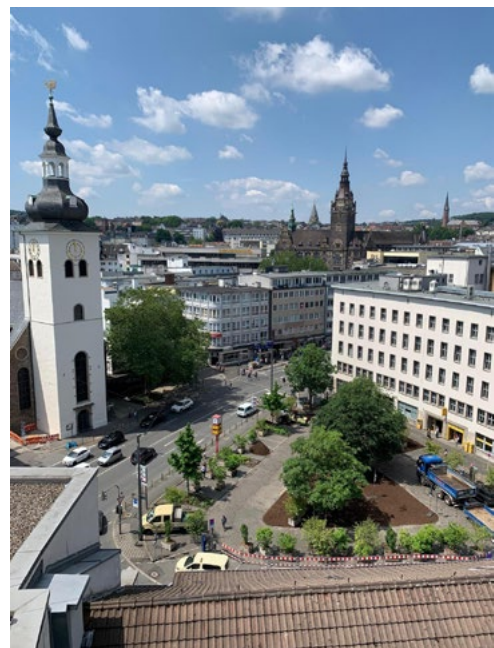
Platz am Kolk nach der Umgestaltung © Stadt Wuppertal
