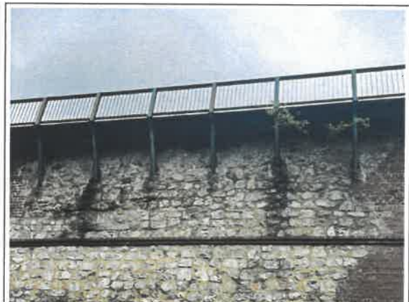
Bild 10: ... im Bereich der Trägereinbindungen.
