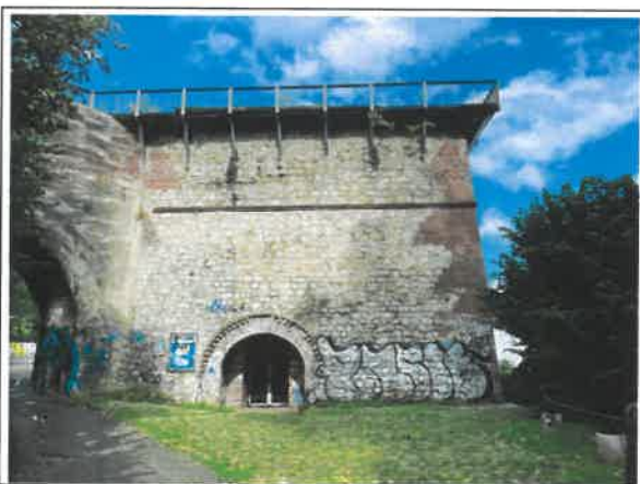
Bild 1: Ansicht des Kalktrichterofens von Westen.
