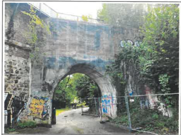
Bild 4: Ansicht der Zufahrtbrücke von Norden.
