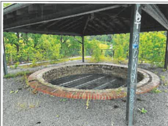
Bild 7: Blick auf die mit einem Gitter gesicherte, überdachte Trichteröffnung.
