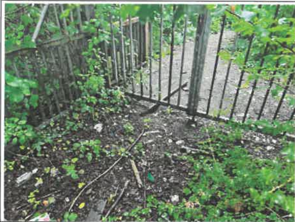
Bild 5: Mit diesem Tor versperrter Zugang zum Bauwerk.
