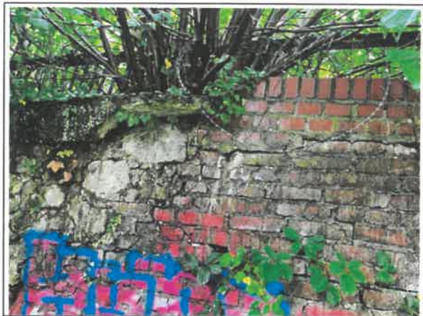
Bild 20: ... neben vermeintlichen Flickstellen aus Ziegelmauerwerk mit aufgemauertem Drempel.
