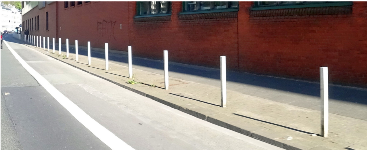
Abb. 1: Pollerreihe mit rund 50 Sperrpfosten.
