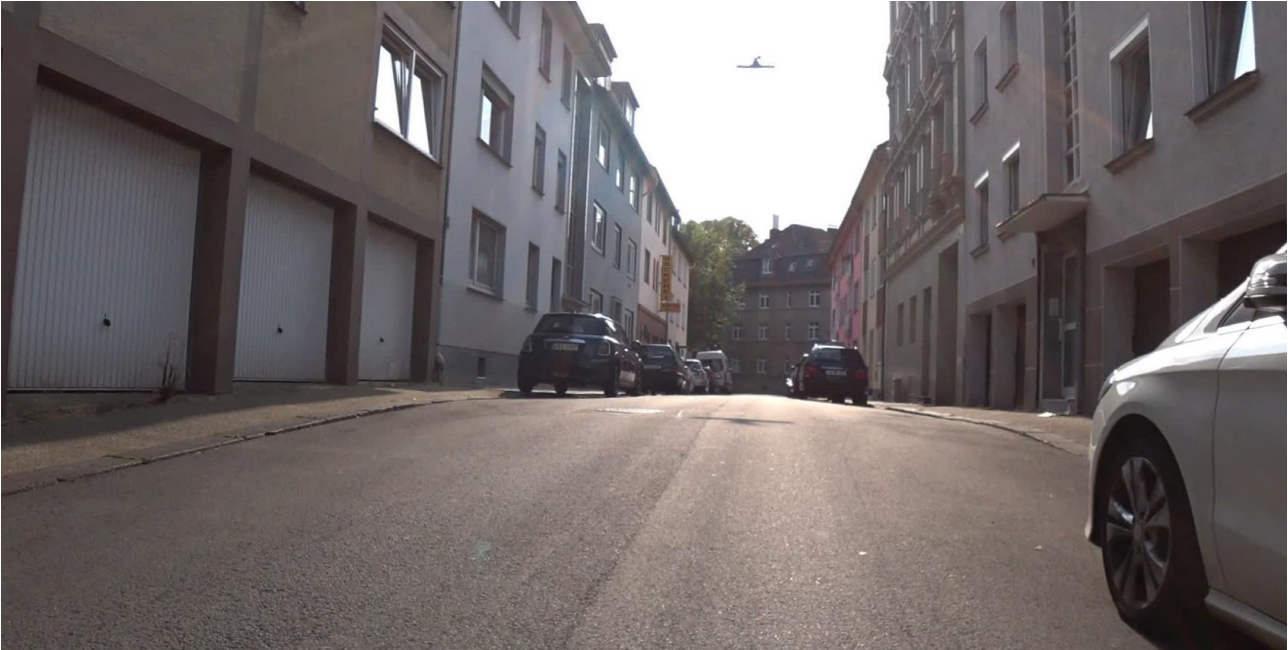
Abb. 14: Zweirichtungsfahrbahn auf der Oberstraße in Höhe Hausnummer 12 westwärts bei einer Fahrbahnbreite um die 6,2 Meter und Parken nach Lust und Laune. Die Durchfahrtsbreite von 3,0 Meter kann nur durch ordnungswidrige Mitbenutzung des Gehwegs erreicht werden. Auch hier sind zwei Fahrstreifen für den fließenden Verkehr völlig illusorisch.
