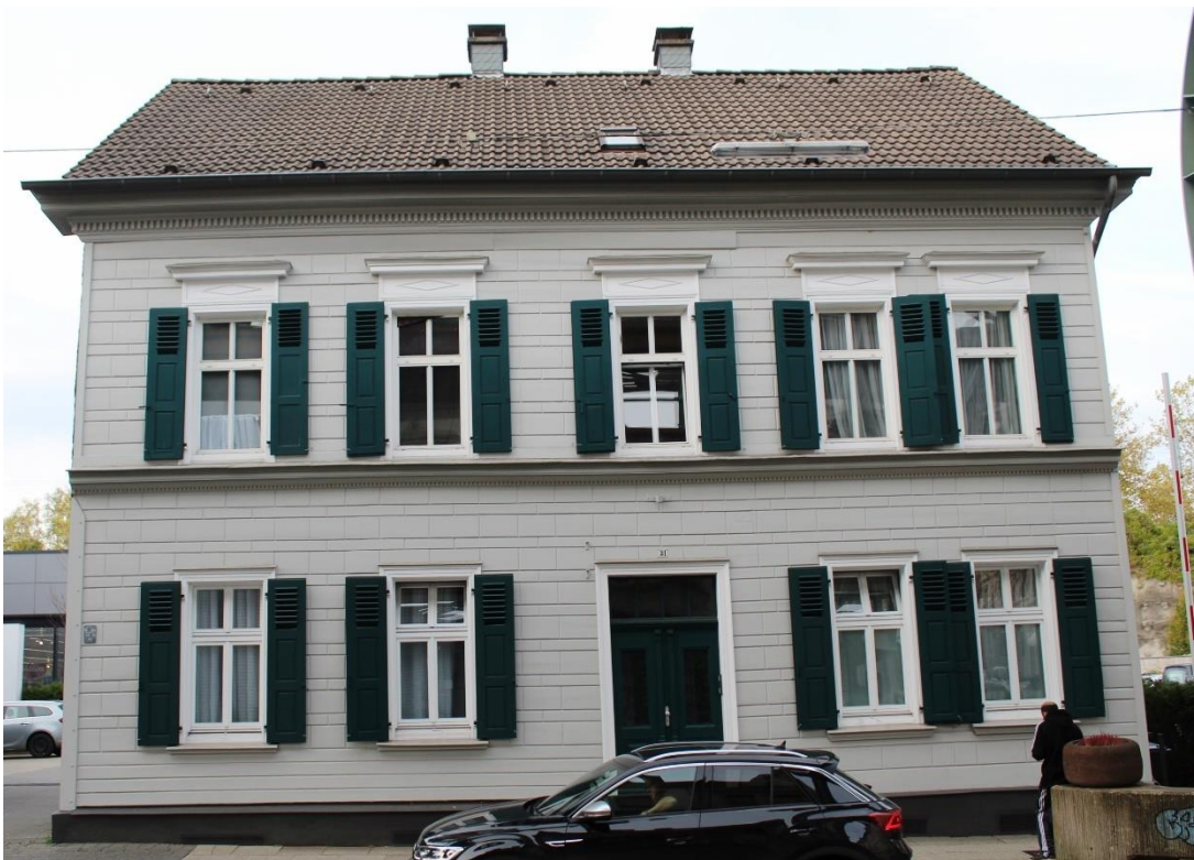
Abbildung 8: Beispiel für ein Gebäude im Bergischen Heimatstil an der Kaiserstr. 31
