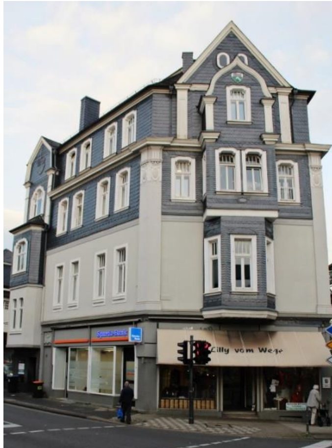
Abbildung 14: Denkmalgeschütztes Gebäude an der Bahnstr. 2
