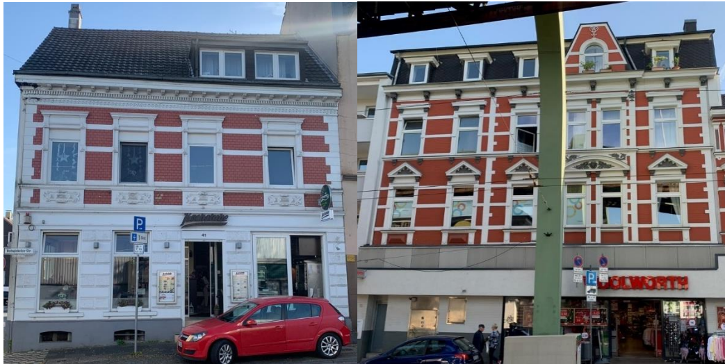
Abbildung 6: Beispiel für nachträglich eingebaute Dachgaube (links) und historisch erhaltene Gauben (rechts)
