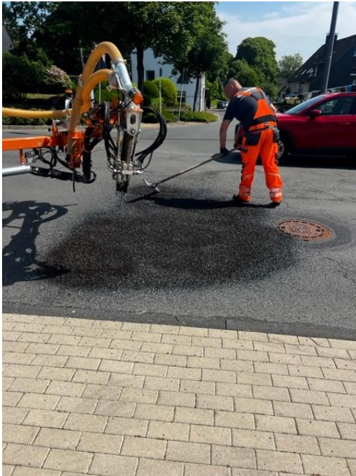
Foto 5: Manuelles Nacharbeiten und Verteilen mittels Schieber
