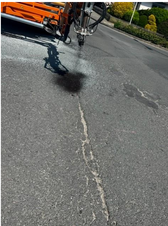
Foto 4: Aufbringen des Bitumensplittgemisches mittels ferngesteuerter Sprühlanze
