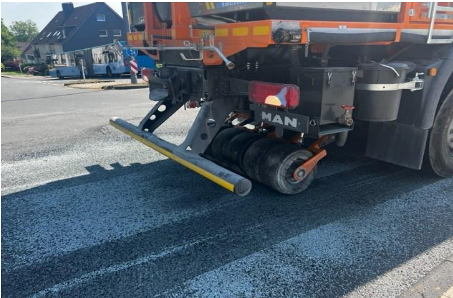
Foto 6: Andrücken der letzten Splittschicht durch am Fahrzeug angebrachten Radwalzen
