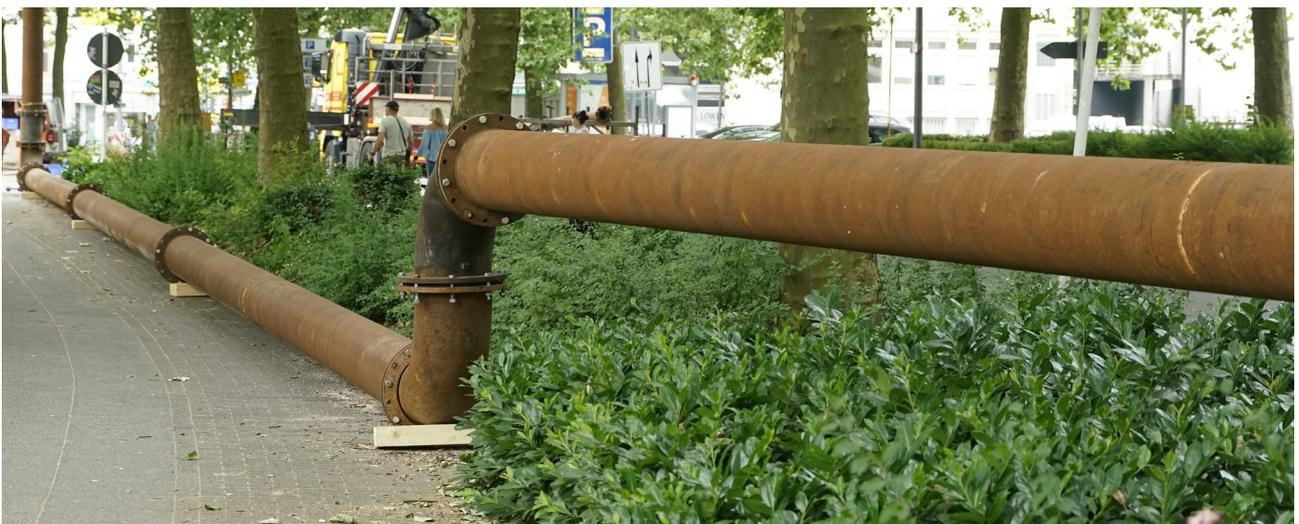
**Foto 5:** Überbrückung des Grünstreifens durch Anhebung des Rohrs.
