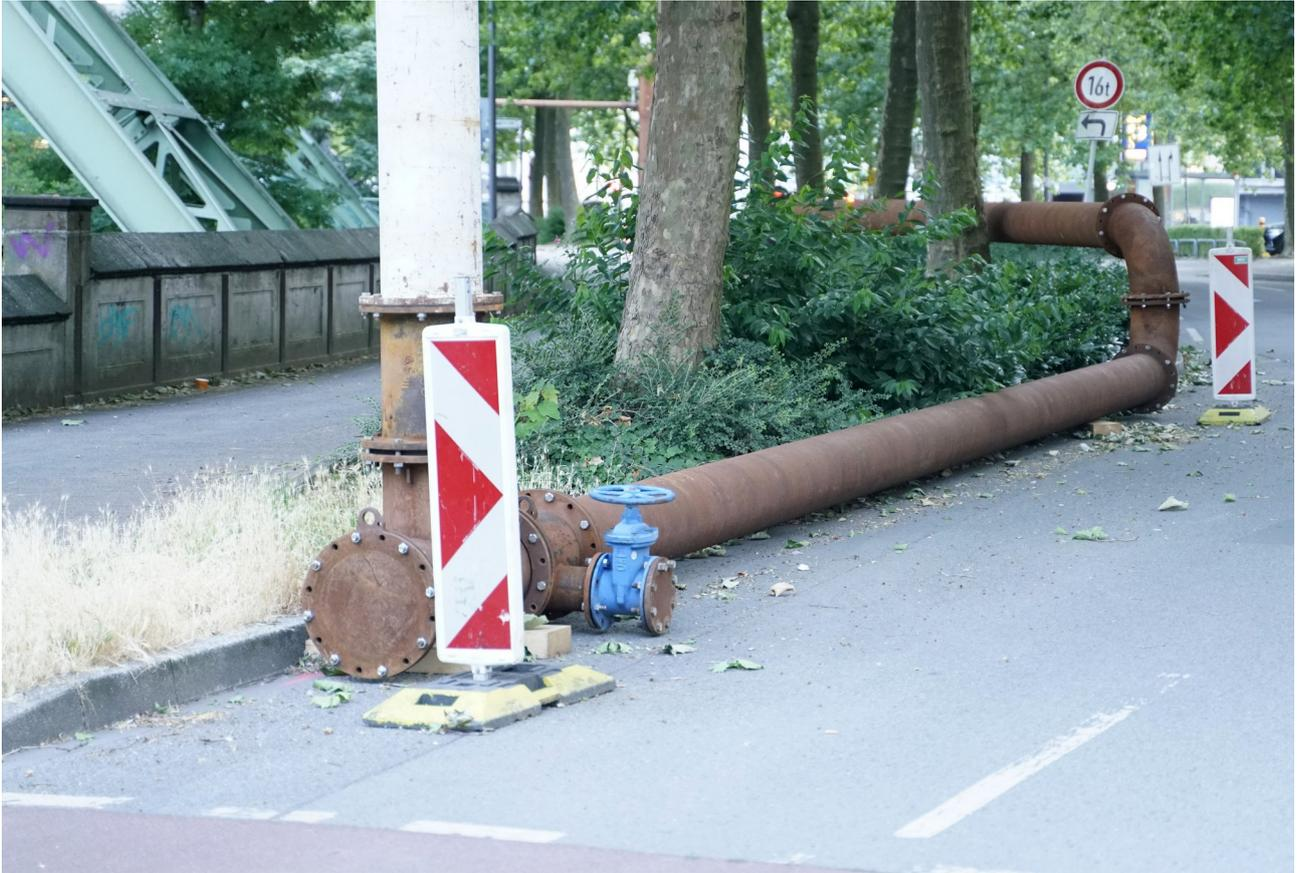
*Foto 6: Weiterführung des Rohrs auf die Fahrbahn und „Sicherung“ mittels zweier unbeleuchteter Leitbake. Eine Betonschutzwand ist stattdessen angemessen (Foto rechts: Wikipedia, gemeinfrei). Im Vordergrund der Radweg Richtung Wall.*
