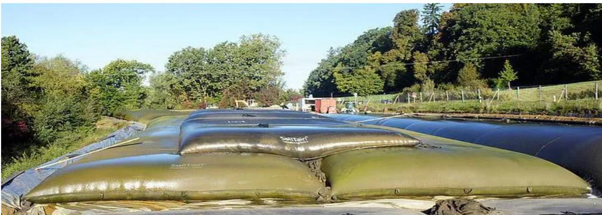
Abbildung 1 – Membran-Entwässerungsschläuche / Quelle: Limus Dredging GmbH)
