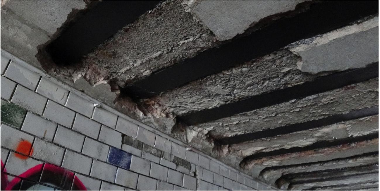
*Abb. 7: In der Unterführung selbst ist der Putz zentimeterdick abgebröckelt.*
