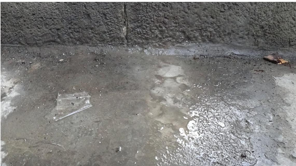
**Abb. 6:** auf der Treppe unterhalb Abb. 4 und 5 wachsende Stalagmiten.
