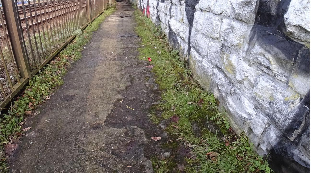
**Abb. 2:** zentimetertiefe Unebenheiten im Boden.
