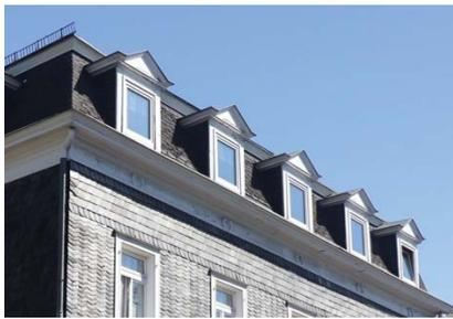
Abbildung 115: Dachaufbauten
