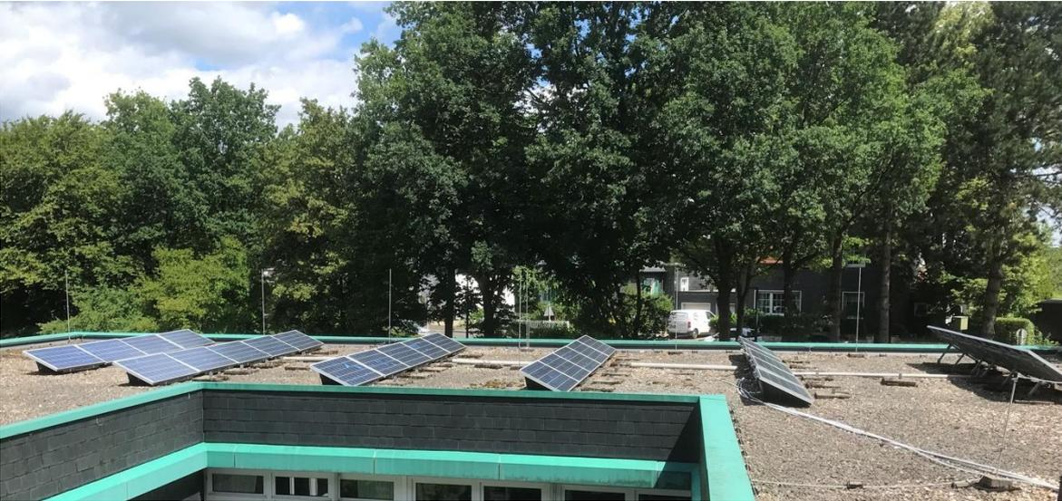
Abbildung 6: Photovoltaik-Anlage auf dem Dach des Schulgebäudes
