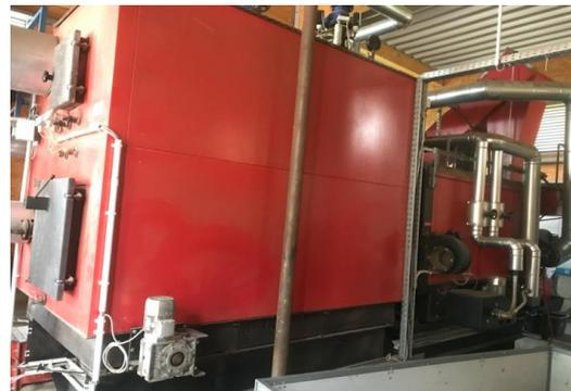
Abbildung 5: Bioflamm Befeuerungstechnik der Holzhackschnitzelheizung
