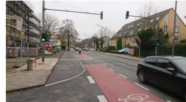
Abb. 19: Städtebaulich verträgliche und angemessene Straßenraumaufteilung auf der Berghäuser Straße
