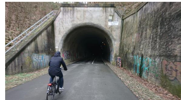
Abb. 55: Tunnelportal an der Nordbahntrasse
