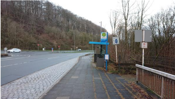
Abb. 56: Unterdimensionierte Führung außerorts
