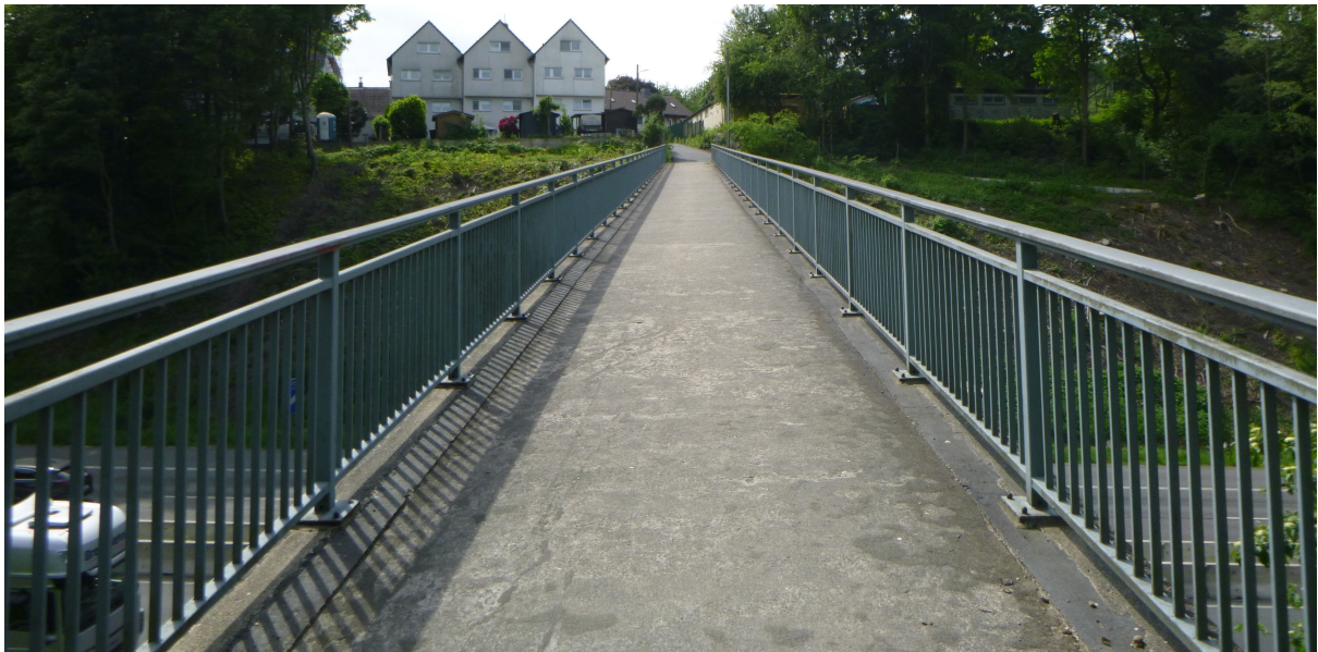
Abbildung 8: Brücke über A46 Fahrbahnbreite 2,5m
