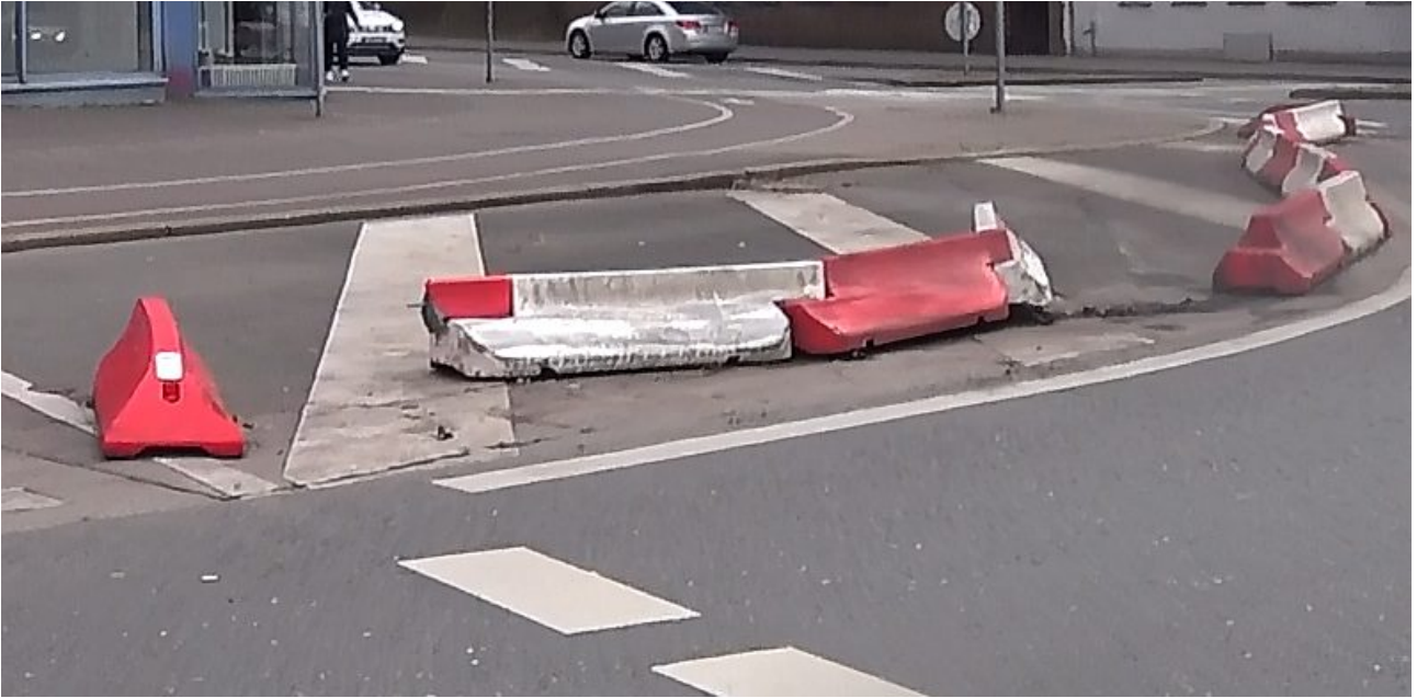
Bild 5: defekte Leitborde März 2021
