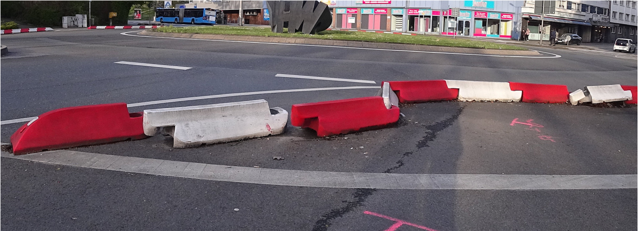
Bild 7: defekte Leitborde Anfang April 2022
