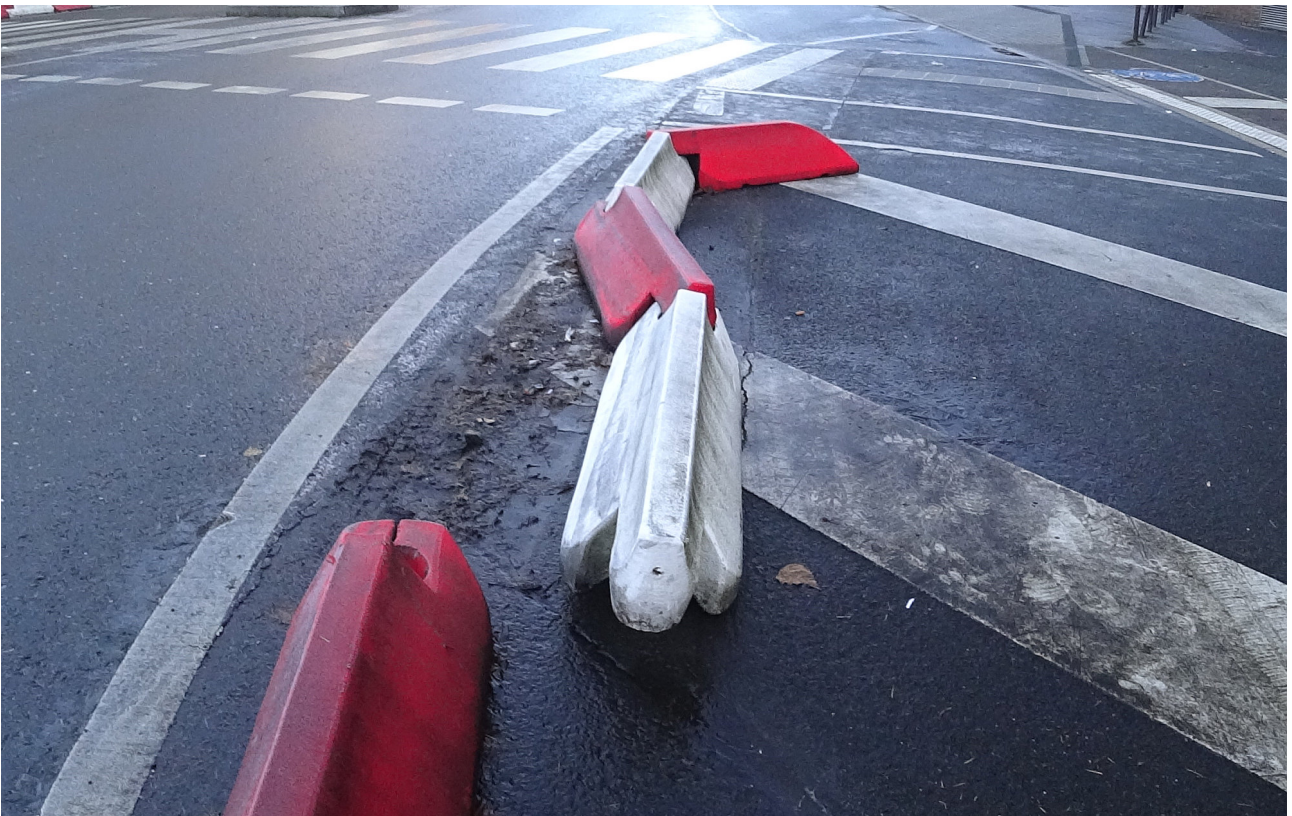
Bild 6: defekte Leitborde Dezember 2021
