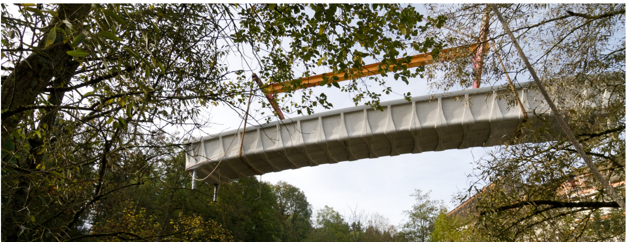
Foto 2: 16,75 m lange Brücke aus Textilbeton über die Rottach in Kempten (Allgäu) für den Fuß- und Radverkehr, 2007. Gewicht: 12,5 t, in Stahlbetonbauweise mindestens 37.5 t, Breite: 2,58 m, kann auch von Schneeräumfahrzeugen befahren werden. 2
