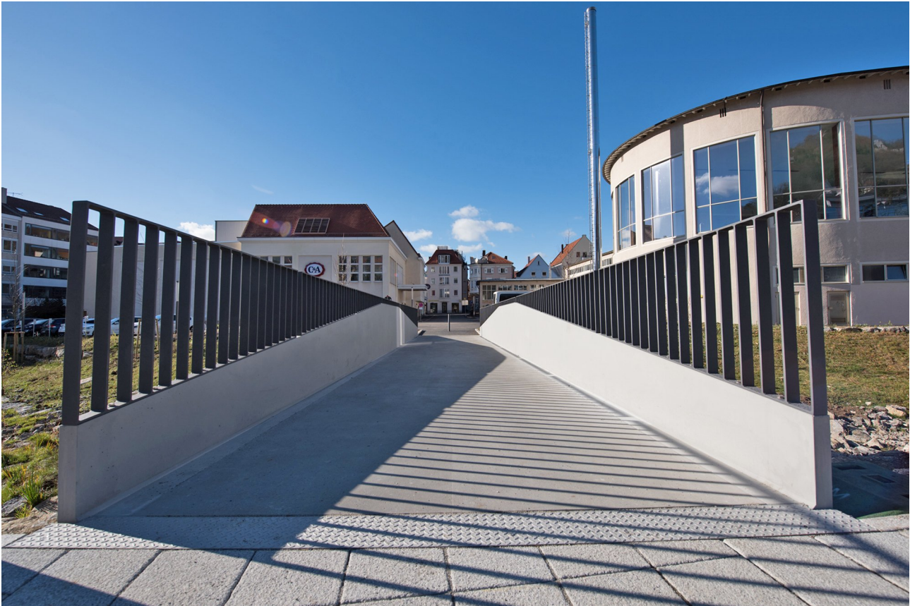
Foto 1: Trogbrücke aus Carbonbeton in Albstadt-Ebingen, 2019. Die Brücke hat eine Breite von 3 m, eine Spannweite von 15 m und ein Gewicht von ca. 14 t. Die Stärke der Fahrbahn beträgt 9 cm, die der der Brüstung 7 cm. Die Brücke kann mit einem Räum- und Streufahrzeug mit einem Gewicht von bis zu 10 t befahren werden..
