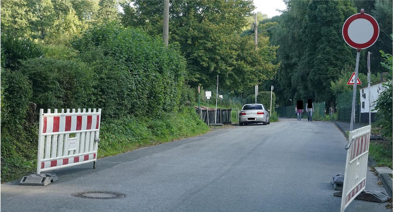
**Bild 6:** Die „Absperrung“ der Baustelle von der anderen Seite: Absturzsicherung irgendwo hingeballert, Fußplatten fehlen, rote Warnlampen fehlen, ein weiteres Zeichen 250. Dieses ersetzt in keinster Weise die Befolgung der StVO und die Verkehrssicherungspflicht des Baulastträgers innerhalb der „Baustelle“.
