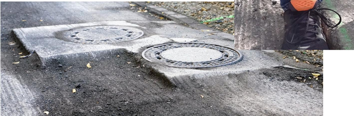
**Bild 7/8:** Die Höhenunterschiede betragen teilweise 6 bis 8 cm, Der Fuß eines Erwachsenen bzw. Kamera verschwindet fast vollständig in dem „Loch“.
