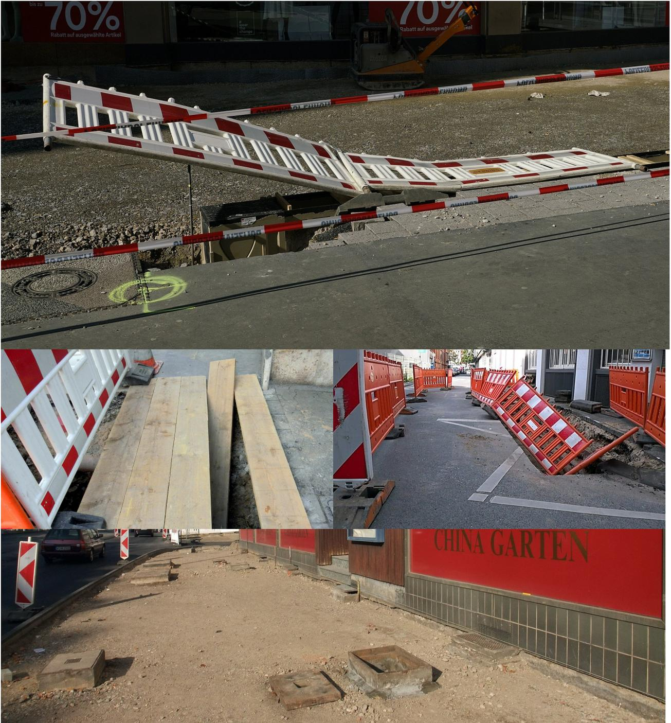
**Bild 1:** Beispiele von „Baustellensicherungen“ aus der Vergangenheit. Absturzsicherungen stürzen ab (Herzogstraße, 2020), lose Bohlen fallen in die Baugrube (Hofkamp), wieder andere Absturzsicherungen sind nicht hinreichend mit Fußplatten gesichert (Zollstraße), Baustelle wird einfach für Fußgänger verboten, aber nicht weiter gesperrt.
