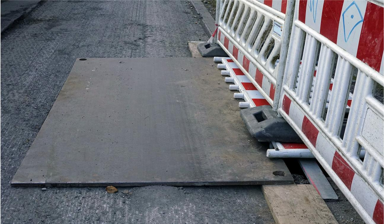
**Bild 9:** Weiteres Highlight: Als „Absturzsicherung“ für die Grube wurde neben der Stahlplatte nicht etwa eine weitere Stahlplatte gelegt, sondern eine Absturzsicherung aus Plastik, die für statische Lasten weder zugelassen, noch konstruiert wurde. Darauf wurden dann Fußplatten lose platziert und darin weitere Absturzsicherung – offenbar eher als Sichtschutz denn als Sicherheit gegen Absturz – lose eingehängt.
