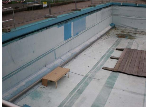
Abbildung 3: Einströmrohre am Beckenboden
