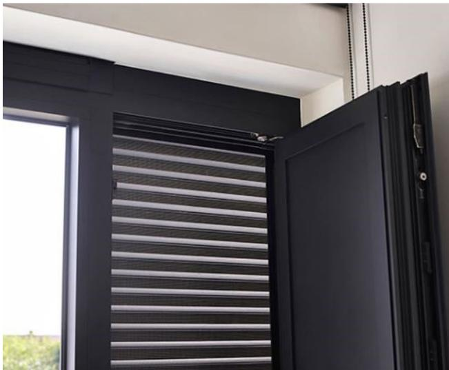
Beispielfoto Fenstersystem mit einbruchhemmendem Lamellengitter (Ansicht von innen)
