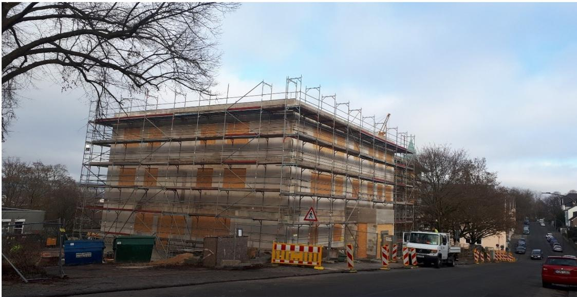
*Eingerüsteter Rohbau, Fenster- und Türöffnungen mit Holzplatten verschlossen als Einbruchs- und Witterungsschutz*
