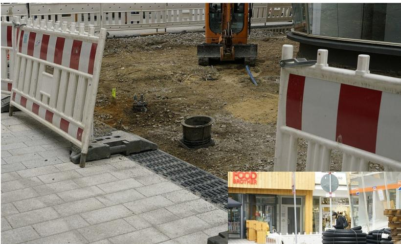
**Bild 5/6:** Aus Bequemlichkeit befinden sich teilweise gar keine Sperren zu den Baustellen.
