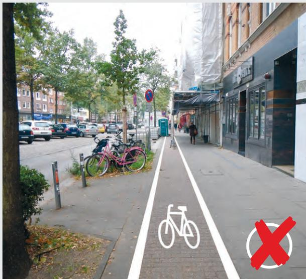
Bild 12 | Gerüst auf Radweg mit schlecht sichtbarer Sicherung
