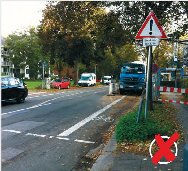
Bild 14 | Arbeitsstelle auf Radfahrstreifen ohne Absicherung
