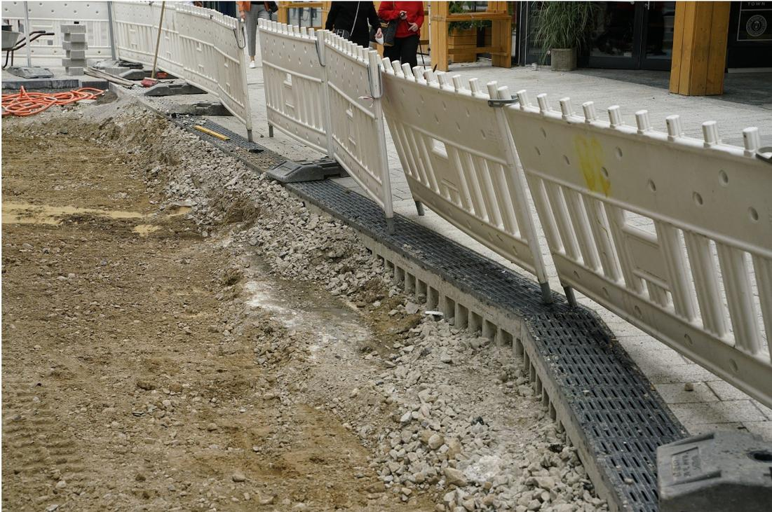
**Bild 4:** Fußgängerzone Herzogstraße. Die aufgestellten Absturzsicherungen sollen dazu dienen, Personen die dagegen laufen, tatsächlich vor Absturz in die Baustelle zu sichern. So wie das hier mit lediglich zwei Fußplatten aufgestellt ist, erfüllen die Absturzsicherungen bestenfalls die Funktion einer Sichtblende.
