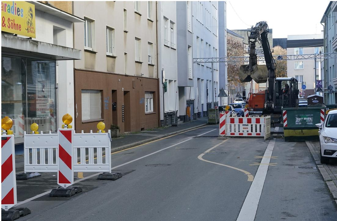
**Bild 2:** Beide Radfahrstreifen enden in der Baustelle, die „mal eben“ erweitert wurde, ohne die zugehörigen Markierungen zu verändern/ergänzen.
