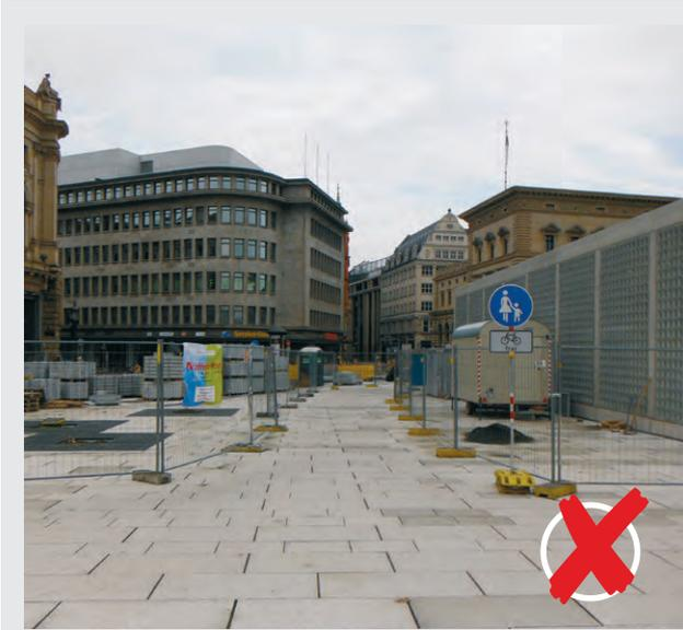
Bild 3 | Schlecht sichtbare Abspernung (z.B. ist im Dunkeln der Zaun nicht sichtbar und die Wegführung schlecht erkennbar).
