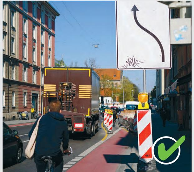
Bild 15 | Arbeitsstelle auf Radfahrstreifen durch Abspernung gesichert
