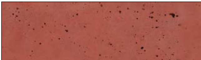
Sichtbeton rot pigmentiert
