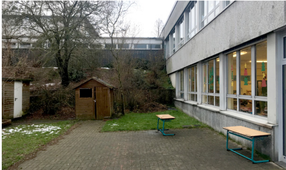
Südfassade mit Terrasse und Ausgang neben dem Betreuungsraum
