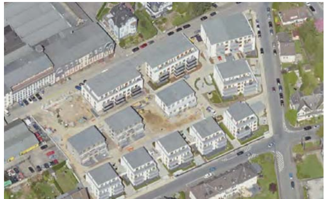
Lessing Quartier Wohngebiet Scheffelstraße/Lessingstraße/ Reuterstraße in Vohwinkel auf ehem. Gewerbebrache
