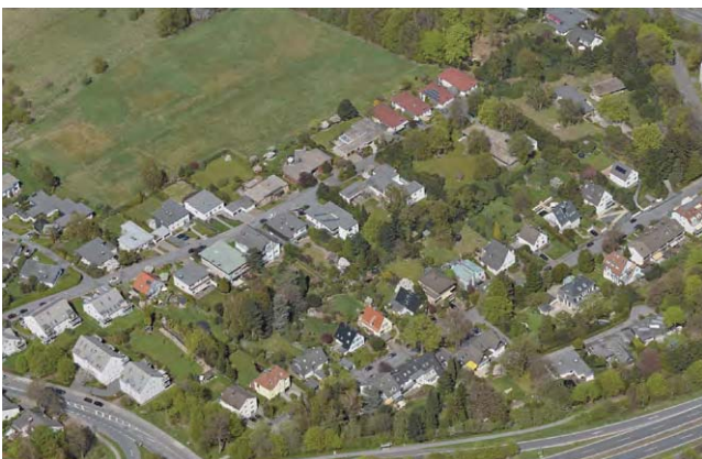
Beispiel Wuppertal-Elberfeld Griffenberg
