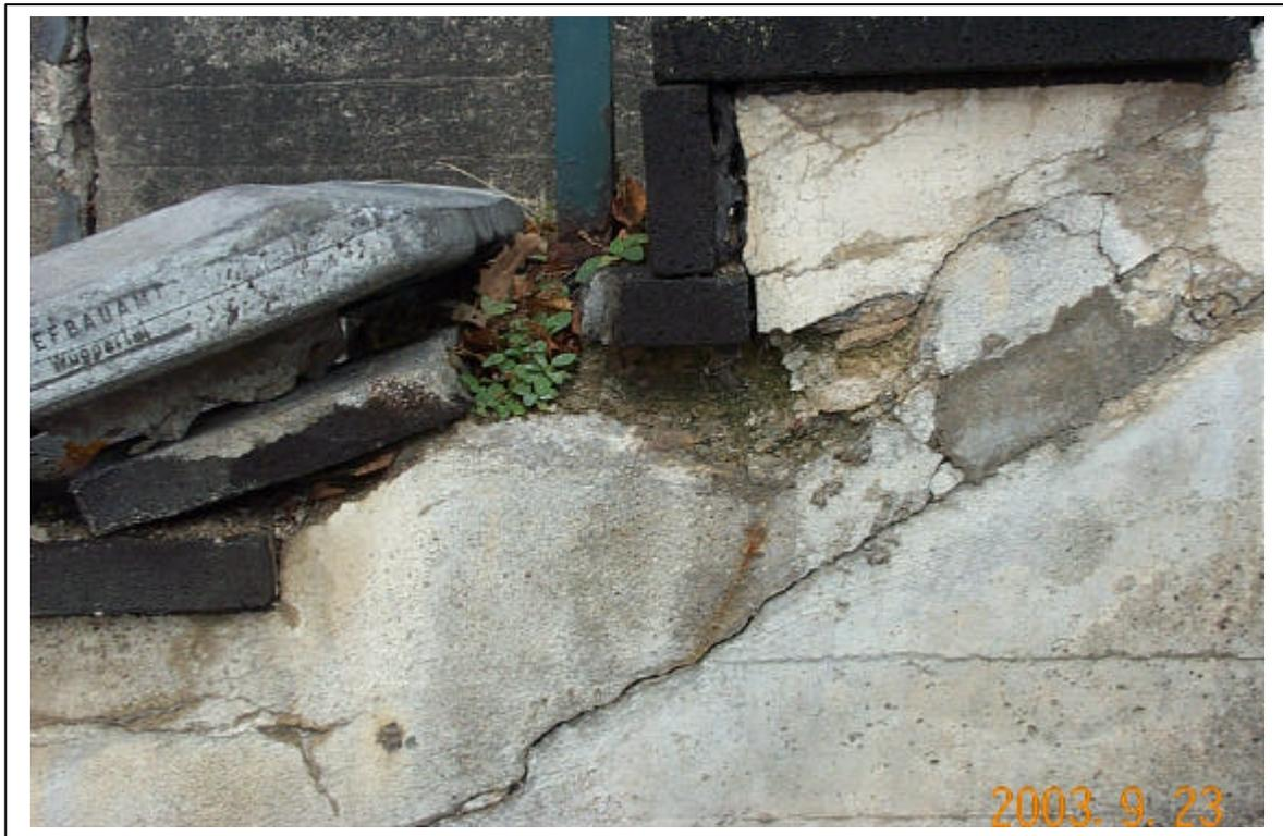
Foto 3 Ausbruchstelle am korrodierten Geländerfuß, gebrochene Betonplatte / Trittstufe
