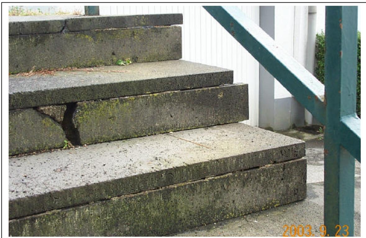
Foto 4 gebrochene und verschobene Betonplatte / Setzstufe
