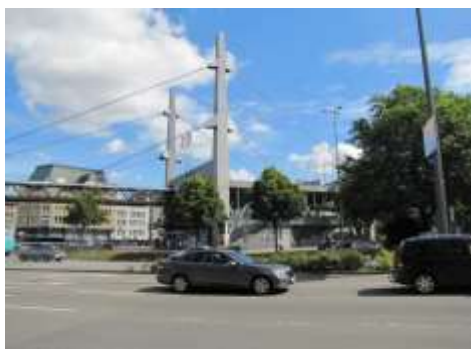
Abb. 51 Schwebebahnpylonen Alter Markt
