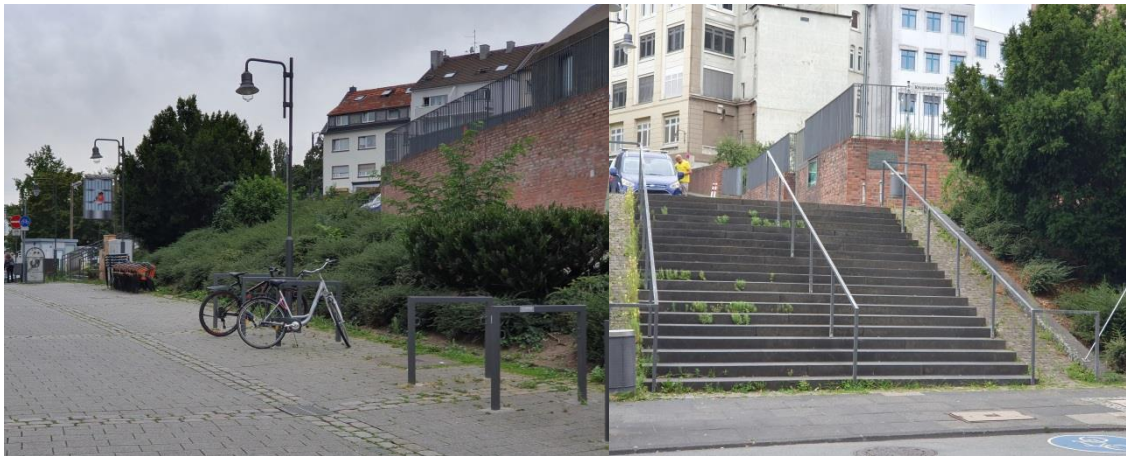
Abbildung 34: Umfeld Begegnungsstätte Alte Synagoge mit der Treppenanlage Genügsamkeitsstraße
