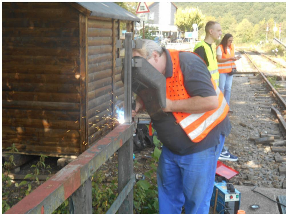
Schweißarbeiten zum Anbringen von neuen Schilderhaltern an der Brücke.
