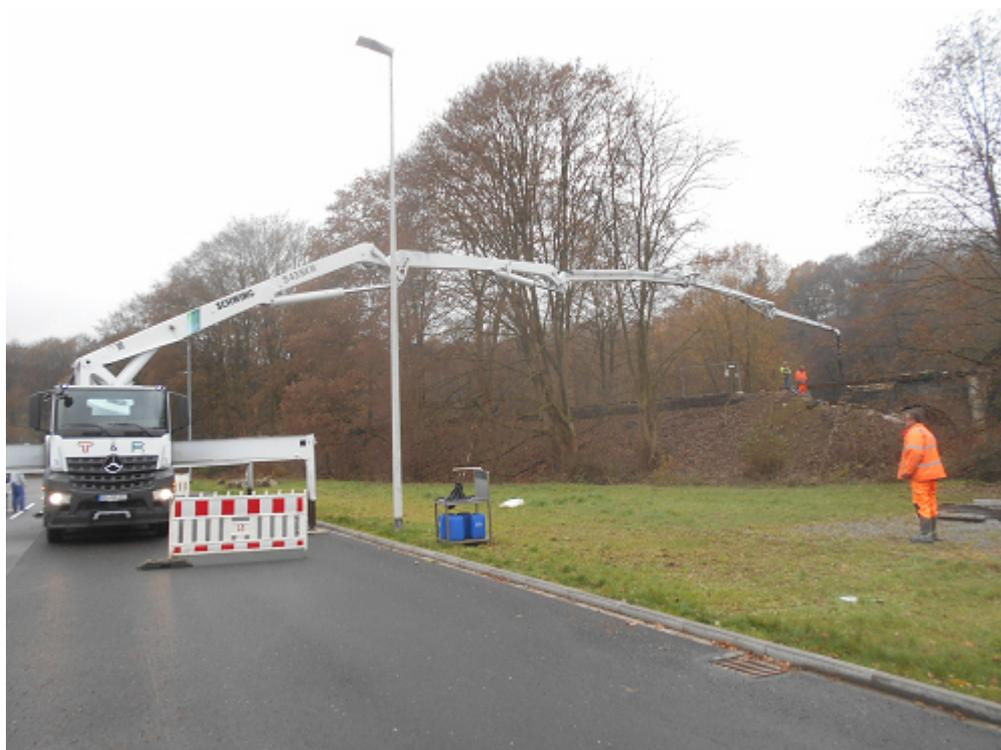
Mit einer großen Betonpumpe wird das neue Beton für das Auflager vom vom Parkplatz der Firma 3M bis zum Einbauort an der Brücke gepumpt.
