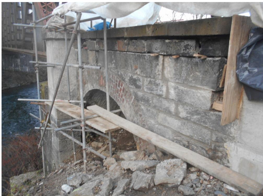
Gerüst mit der im unteren Bereich und am Gewölbe neu verputzten Wand
