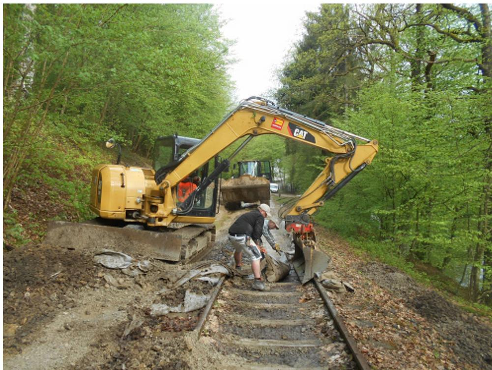
Rückbau der Baustraße und Säuberung der darunter liegenden Gleisanlagen.
