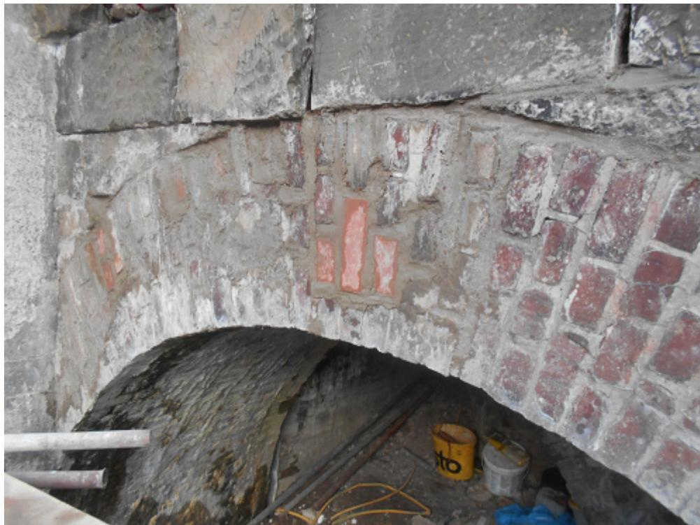
Ausgebessertes Gewölbe. Teilweise mussten neue Ziegel eingesetzt werden.
