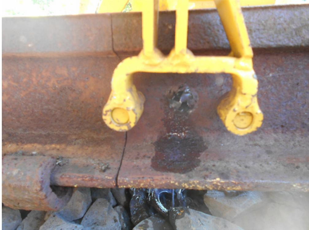
Hier eine Bohrung im Detail. Der Bohrer kommt gerade durch die Schiene.
