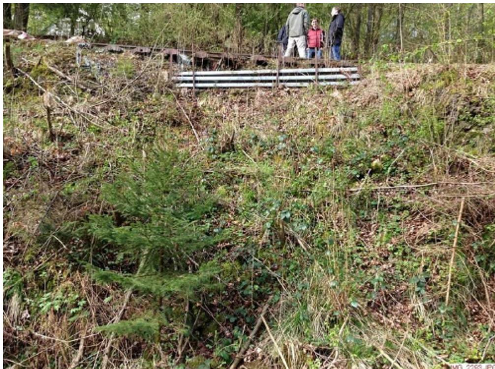
Der Hangrutsch wie er sich fast 20 Jahre gezeigt hat. Man kann erkennen, dass die Gleise in der Luft hängen, sodass an Bahnverkehr nicht mehr möglich ist
