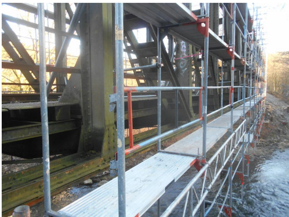
Das Arbeitsgerüst im Bauzustand außen an der Brücke (Oberstromseite)
