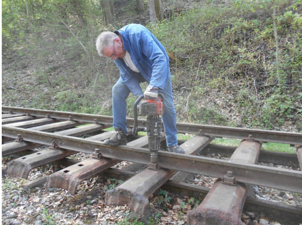
Zwischenzeitlich wird an dem ausgebauten Gleis ein Wechsel der beschädigten Schwellen durch die Ehrenamtler der Wupperschiene durchgeführt.
