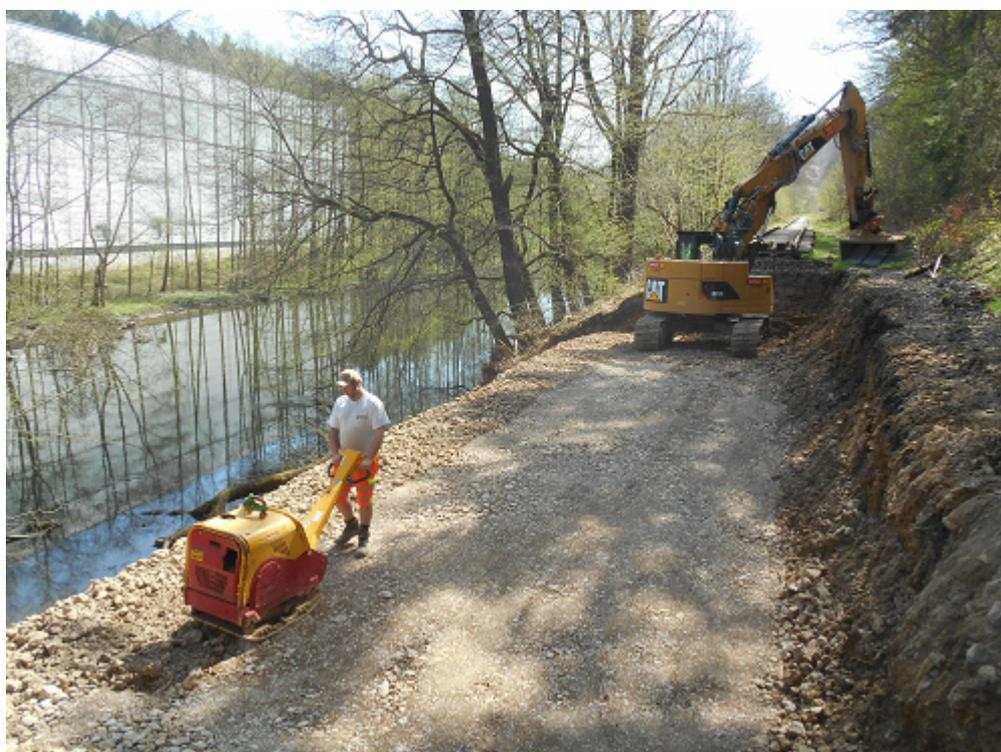
Untergrundverdichtung des Hauptplateaus mit einer großen Rüttelplatte.
