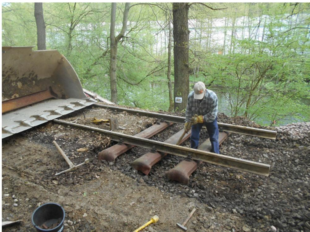
Hier erfolgt ein Austausch von durch die Baumaßnahme beschädigten Schwellen
