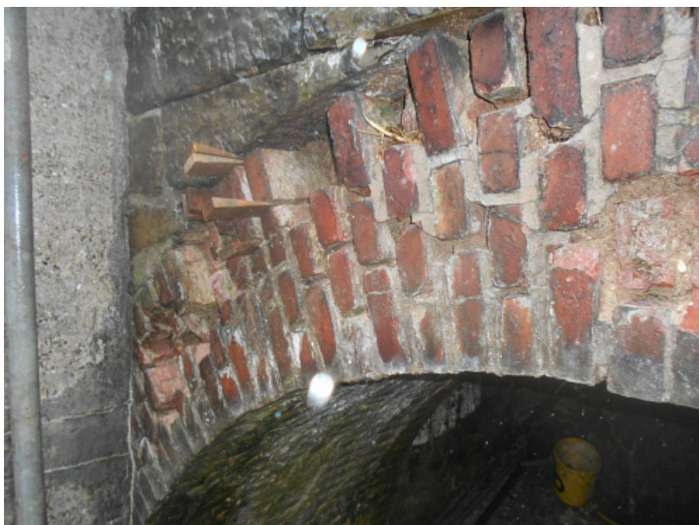
Schäden und Ausbrüche am Ziegelsteingewölbe unter der der Vorbrücke.
