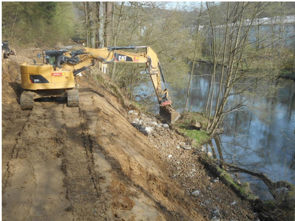
Der Bahndamm wird mit speziellen Steinen vom Fuß her neu aufgeschichtet.
