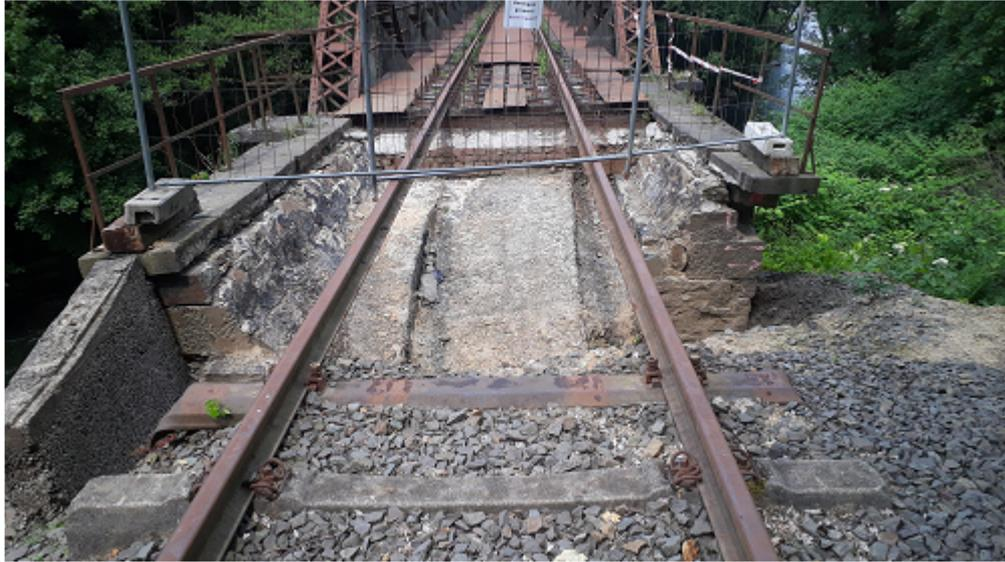
Freigelegtes Gewölbe als Vorbereitung zur Gründung einer neuen Tragkonstruktion. Der Aushub wurde durch die GBA Wuppertal im Vorfeld erledigt.
