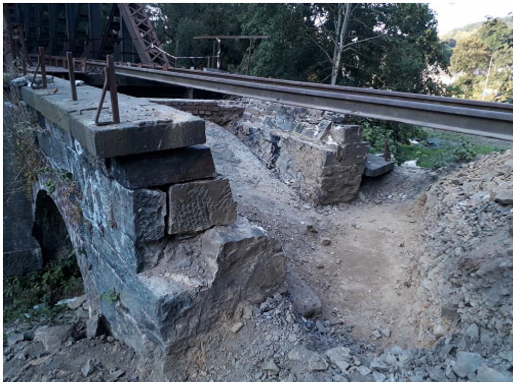
Das neue Auflager wird an dieser Stelle entstehen. Die defekten und teilweise weggekippten Wände der Vorbrücke zu erkennen, die nicht mehr tragfähig sind.
