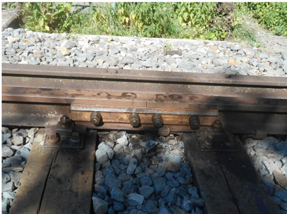
So sieht dann zum Schluss ein fertig zusammen geschraubter Schienenstoß aus.
