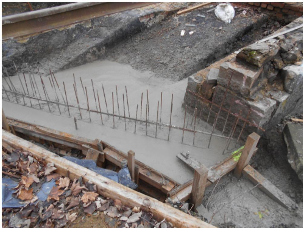
Der 1. Betonierabschnitt ist fertig gestellt. Man erkennt die Anschlussbewehrung
