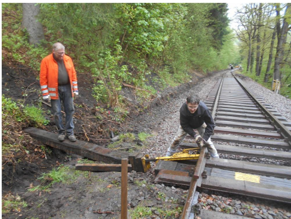
Ausrichten des Gleisjochs in der Lage und in der Höhe. Wie auch die restlichen Arbeiten am Gleis wird dies durch die Vereinsmitglieder in Eigenregie erledigt.
