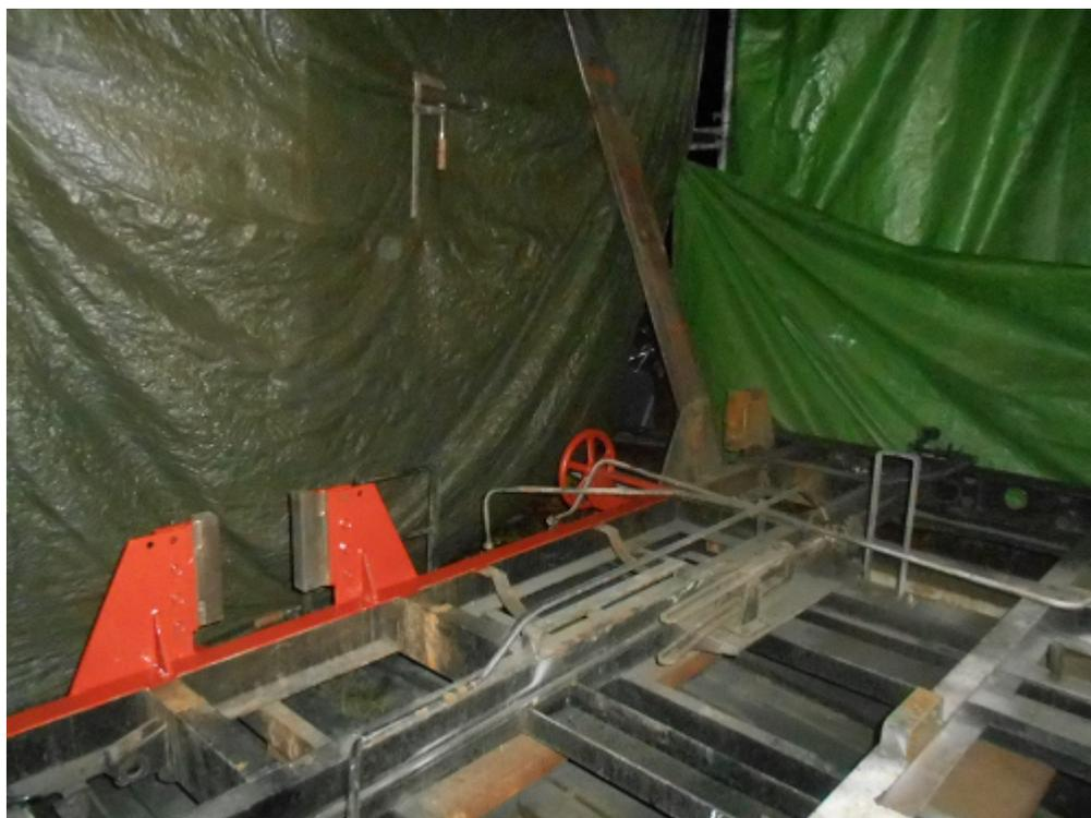
Die ersten Bereiche werden mit einer Schicht aus Rostschutzgrund versehen.
