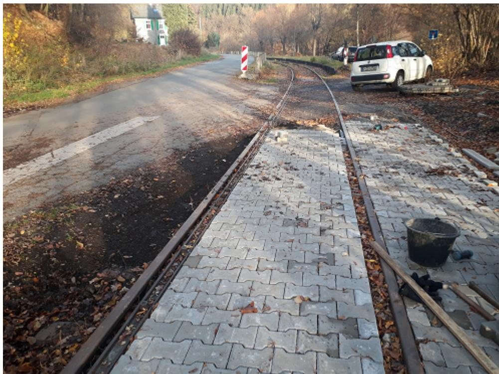
Am Streckenende in Wilhelmsthal entsteht ein Drehplatz mit Bahnsteig. Dies ermöglicht auch ein barrierefreies Aus- u. Einsteigen bei den Rollstuhldraisinen
