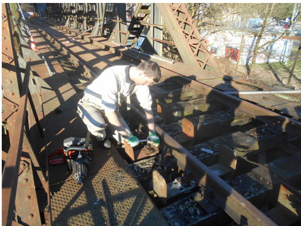
Rückbau von Hilfsbrückenelementen, bevor der Ausbau der Brückenbalken Starken kann. Auch diese Arbeit leistet der Verein Wupperschiene selber.
