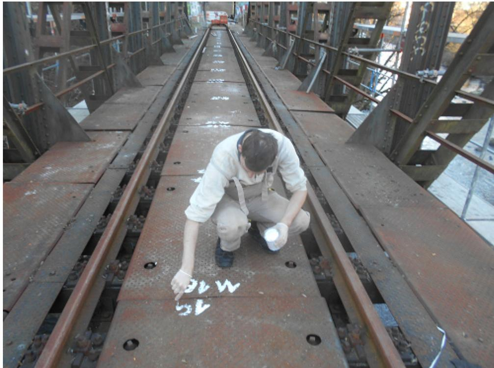
Bevor die Abdeckbleche zurückgebaut werden, werden sie fortlaufend beschriftet
