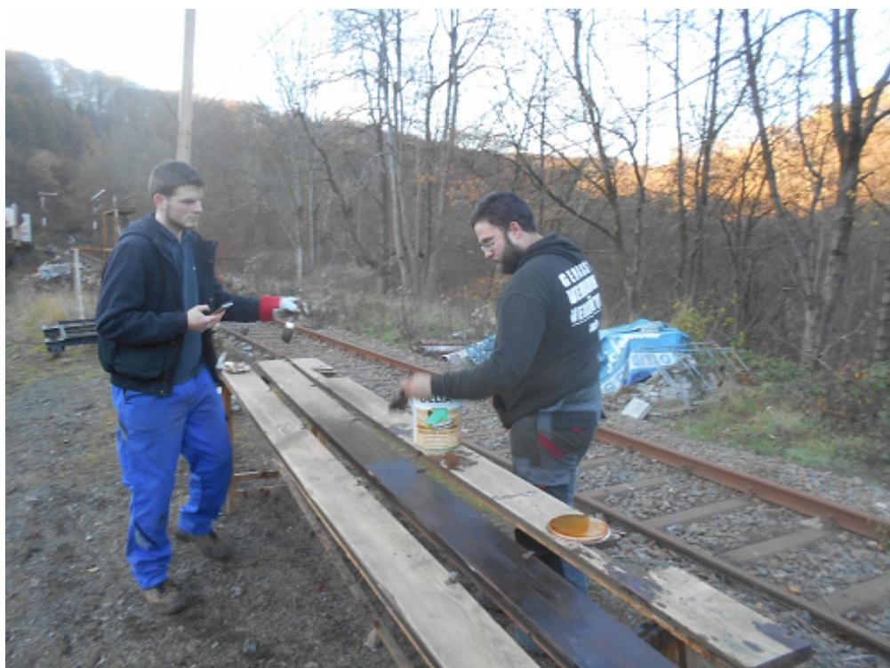
Die Bretter vom Fahrzeugboden werden mit Holzschutzlack bearbeitet.
