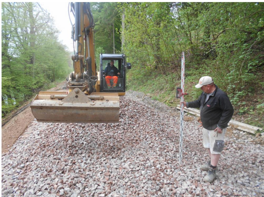
Einbau Grundsotter. Der letzte Schritt bevor das Gleis wieder eingebaut wird.
