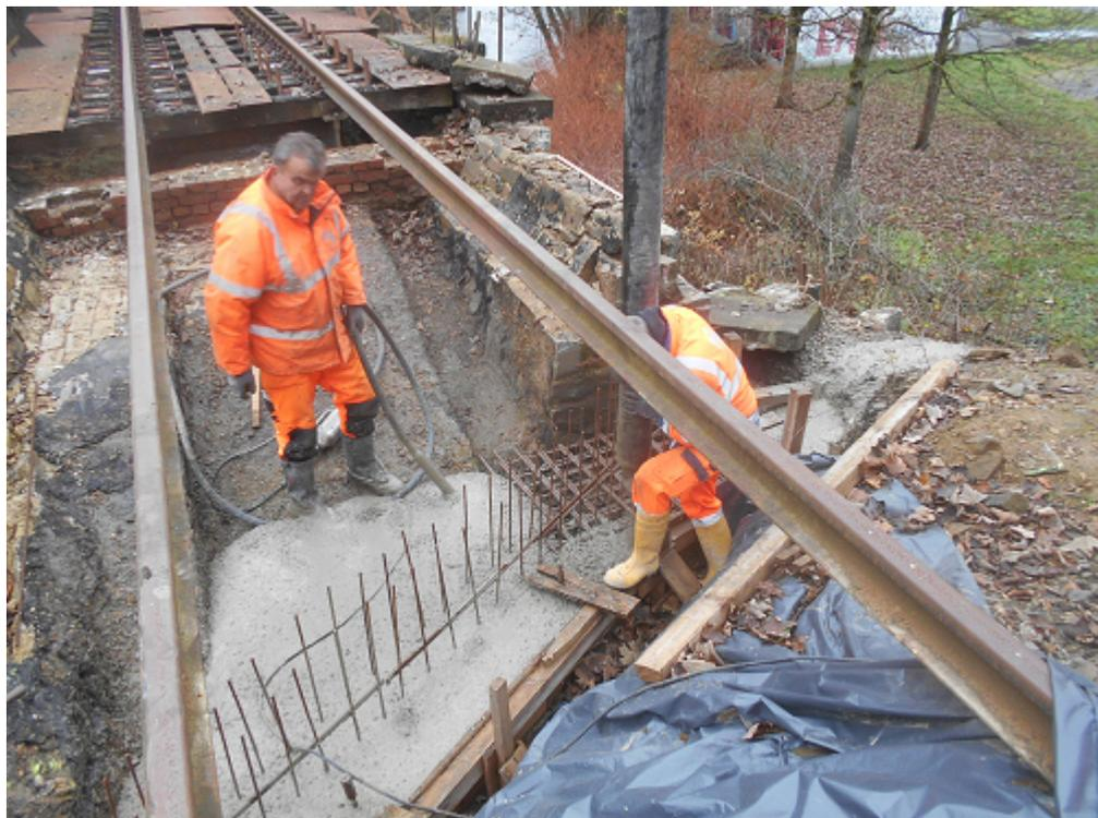
Betonarbeiten am neuen Brückenlager der Vorbrücke.
