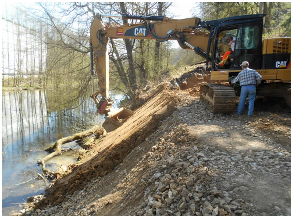
Eindecken der neuen Böschung mit Oberboden, der später noch begrünt wird.
