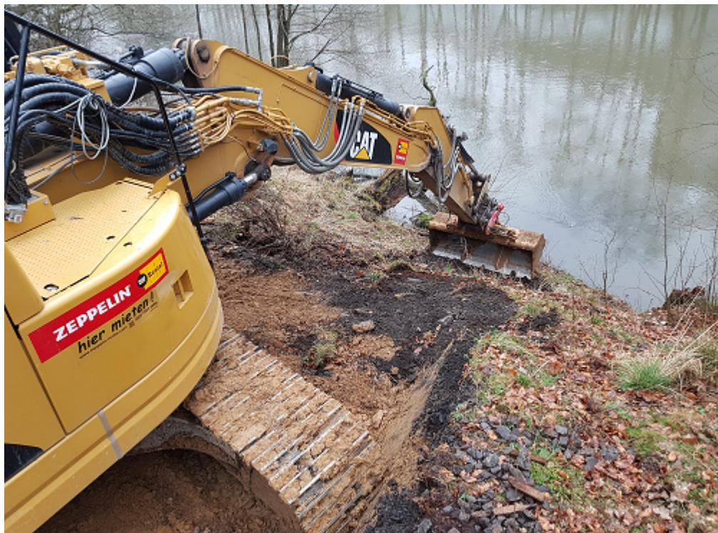
Der Erdaushub erfolgt in mehreren Etappen bis fast auf das Niveau der Wupper
