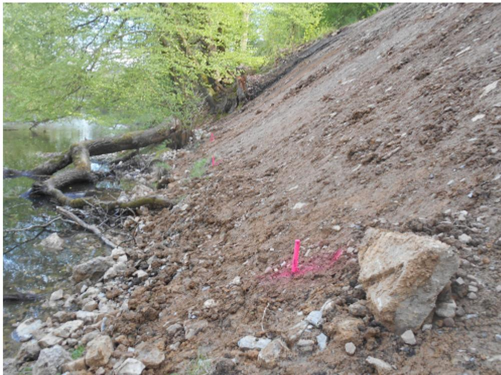
Im gesamten Baubereich werden Messpunkte eingebaut, durch die ein Vermesser im Nachgang auswertet, ob die neue Böschung tatsächlich so stabil ist, wie nötig.
