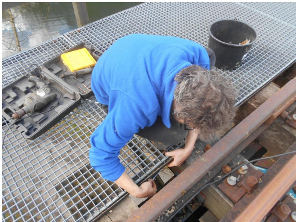
Montagearbeiten an den Gitterrosten des Brückenrandweges vor Draisinenstart.
