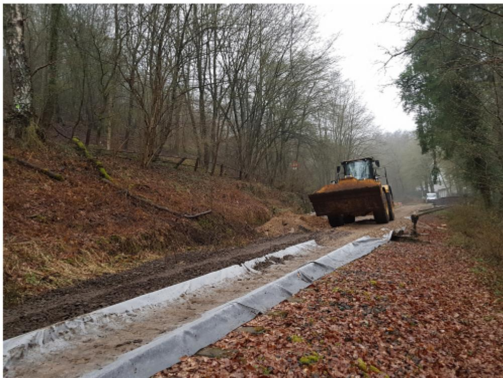
Der Start der Baumaßnahme ist die Errichtung einer Baustraße auf einer Länge von rund 200m vom Bahnübergang zum Hangrutsch für Materialtransport
