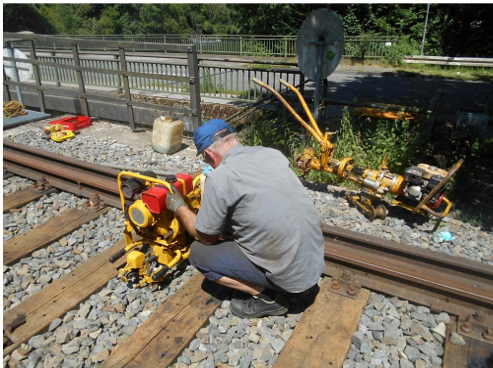
Mit einer speziellen Schienenbohrmaschine werden Löcher in die Schienen gebohrt, damit diese nachher miteinander verschraubt werden können.
