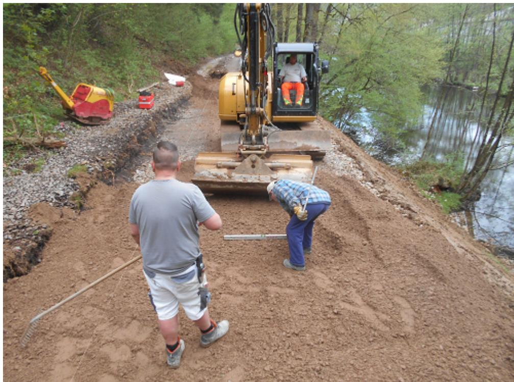
Einbau und Nivellieren einer Planumsschutzschicht auf der neuen Böschung
