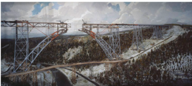
fig. 1: Müngsten Bridge under construction (© Deutsches Museum, München)
