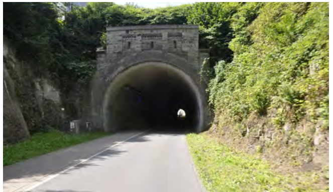
Abb. 19 Für Bahntrassen wurden Tunnel durch die bewegte Landschaft gebaut, davon profitieren heute Radfahrende
