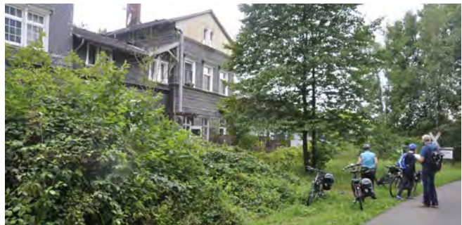
Abb. 95 noch nicht umgewidmeter Bahnhof Wald
