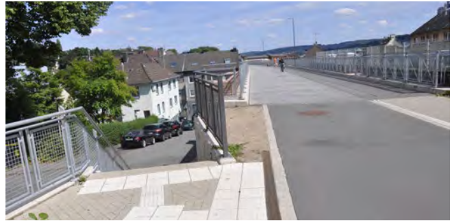
Abb. 85 Viadukt-Abschnitte sind nur schwer zugänglich, Nordbahntrasse
