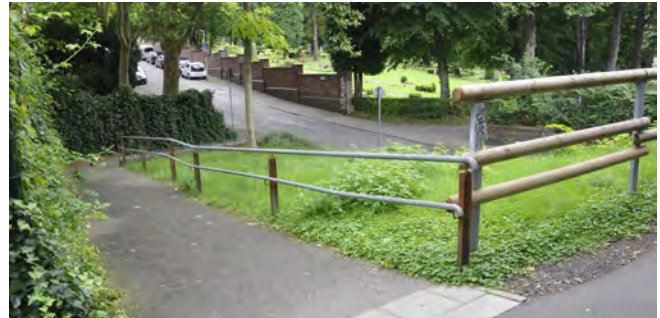
Abb. 86 Zugang an Korkenziehertrasse, auf Damm verlaufend
