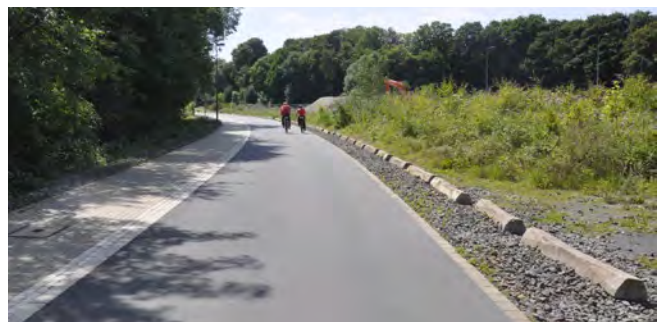
Abb. 89 wertvolle, noch brach liegende Freiräume am ehemaligen Bahnhof Heubruch an der Nordbahntrasse
