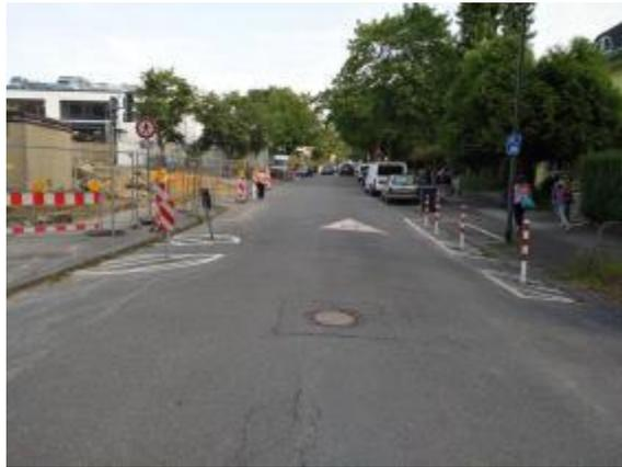
Abbildung 34: Provisorische Einrichtung einer Überquerungshilfe im Schulumfeld.
