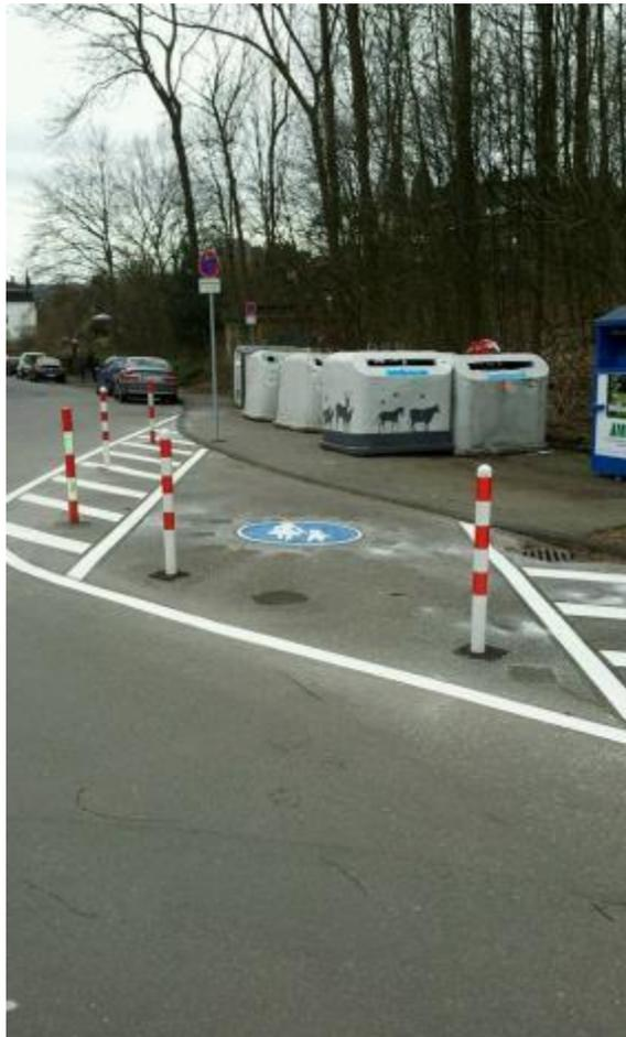
Abbildung 37: Erneuerung der Markierungen und Ergänzung von Pollern, um das Befahren mit Kfz zu verhindern.
