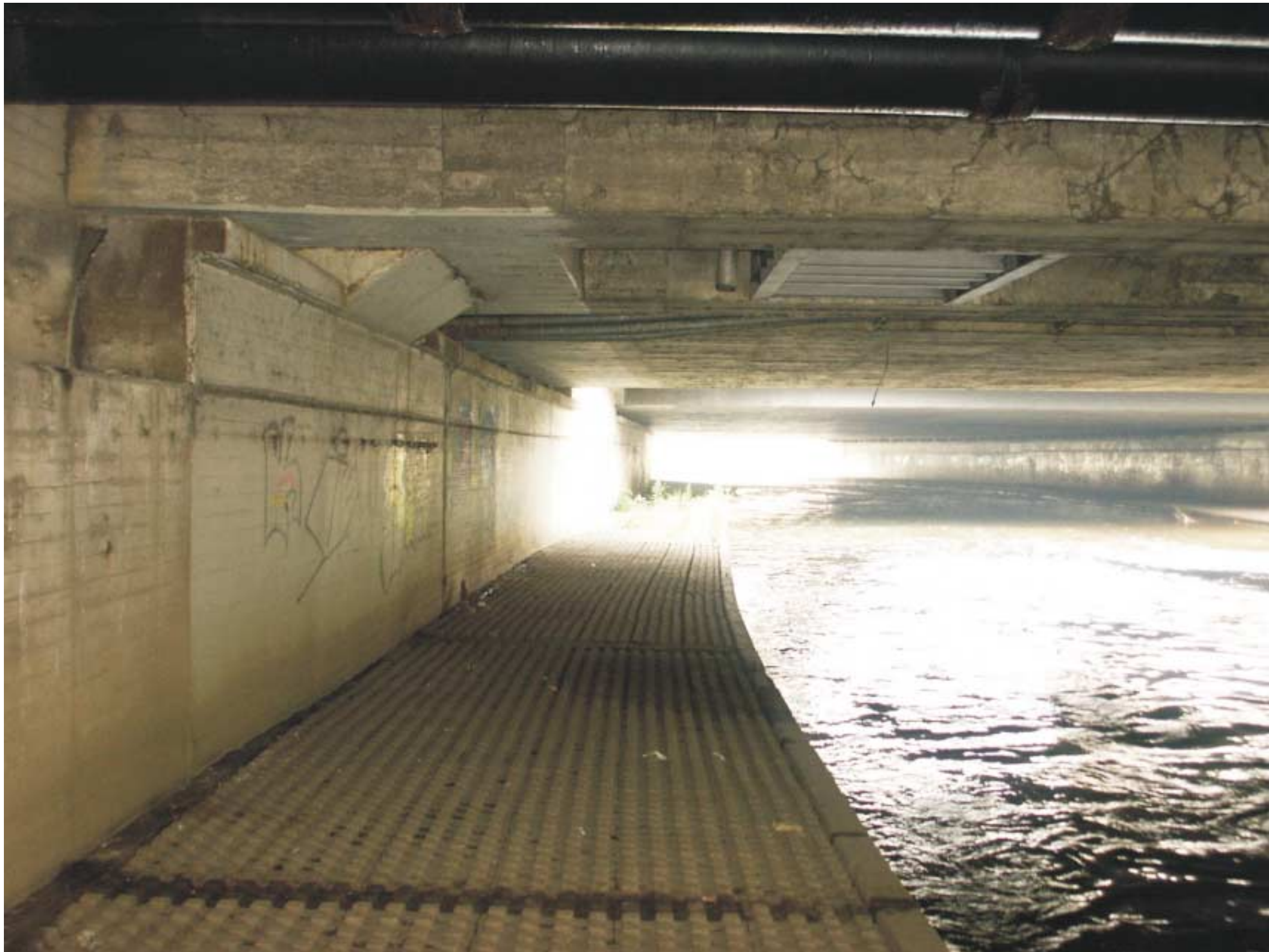
Berme unter Kreuzung Steinweg / B7
