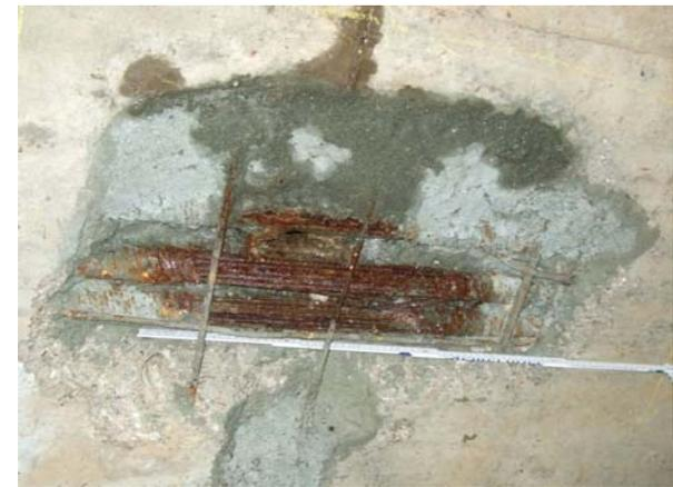
Kluse: Korrodierte Spannfitzen
