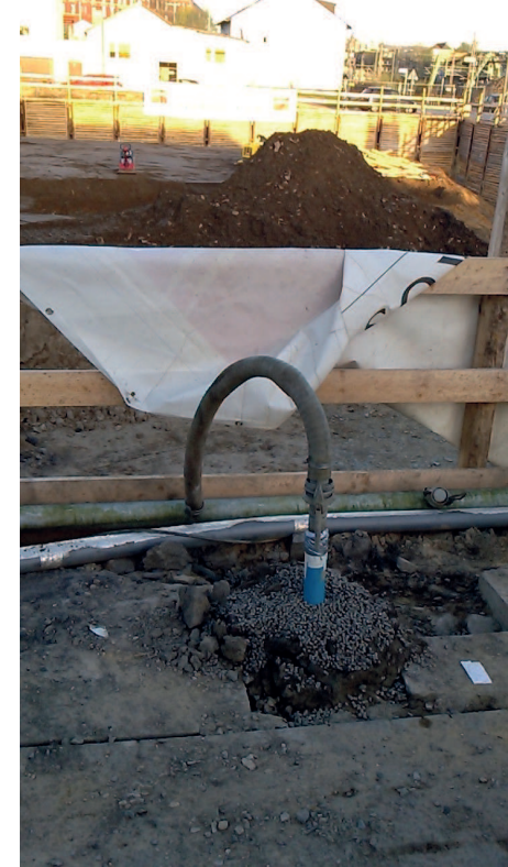
Grundwasserabsenkung im Anstrom
