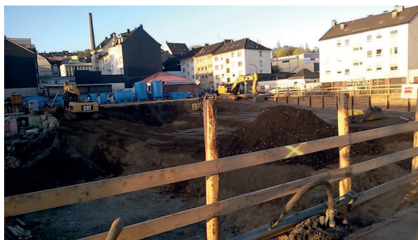
Sanierte Fläche mit Grundwasser Reinigungsanlage
