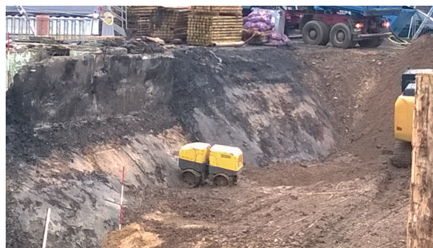
Verfüllen mit sauberem Boden
