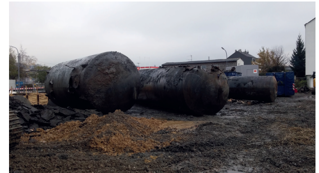
Ausgebaute und gereinigte Tanks
